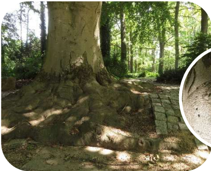
Les puissantes racines du hêtre déforment la chaussée
