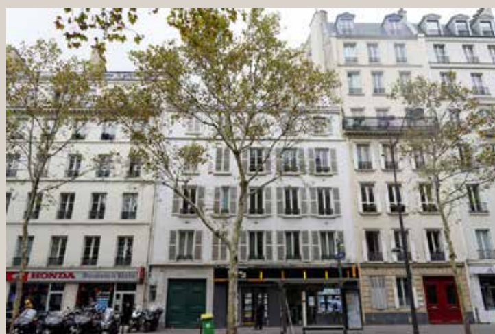
Vue actuelle de la façade sur rue.
