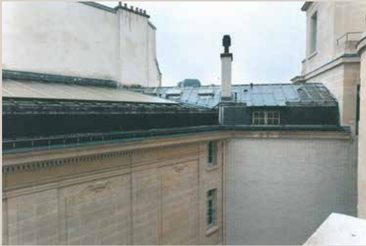
Vue actuelle de la toiture, qui serait transformée (© B. Architecture).
