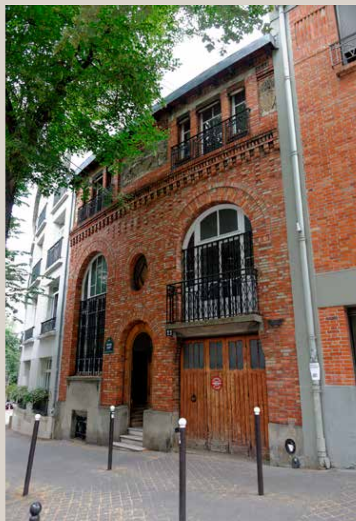
Vue de la façade sur rue.
