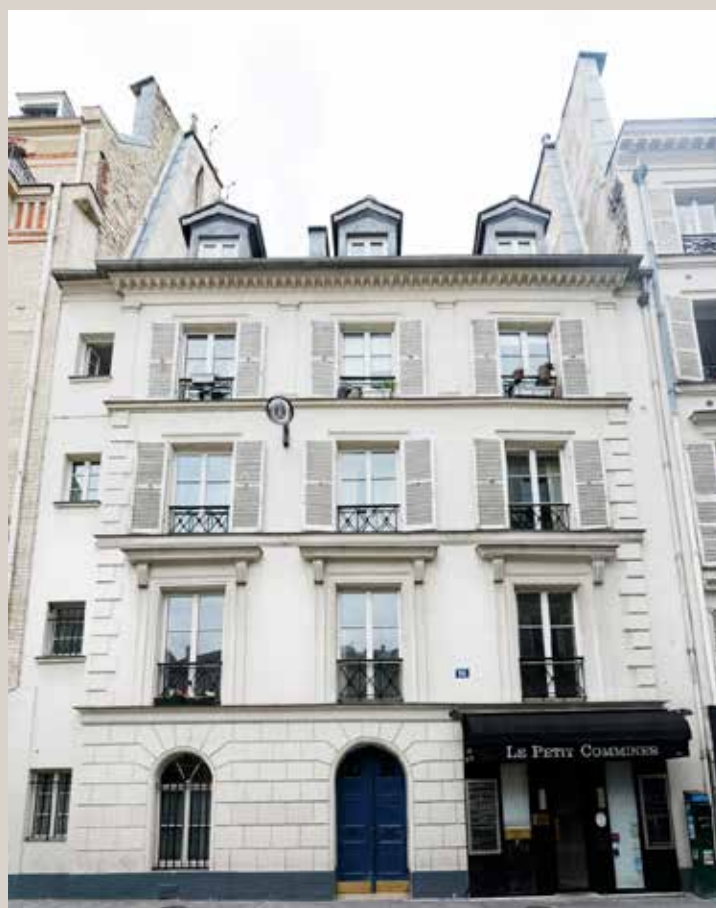
Vue actuelle de la façade sur rue.
