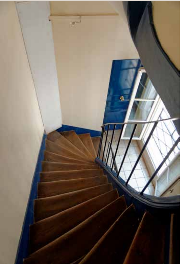
Vue actuelle de l’escalier tournant.
