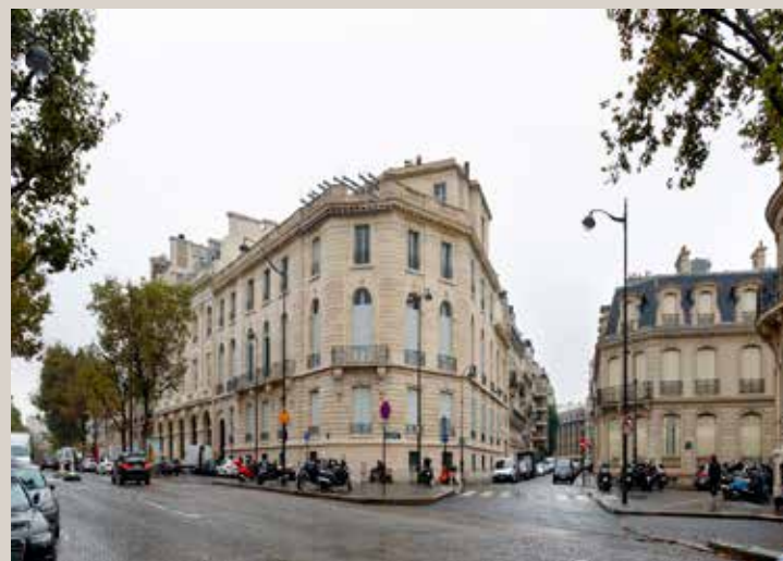
Vue actuelle de l'immeuble depuis l'avenue d'Iéna.
