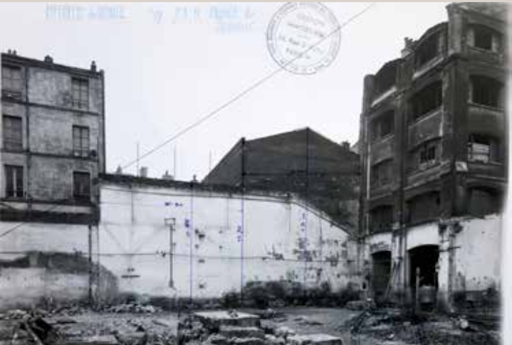
Vue des démolitions engagées en 1950 (Archives de Paris).
