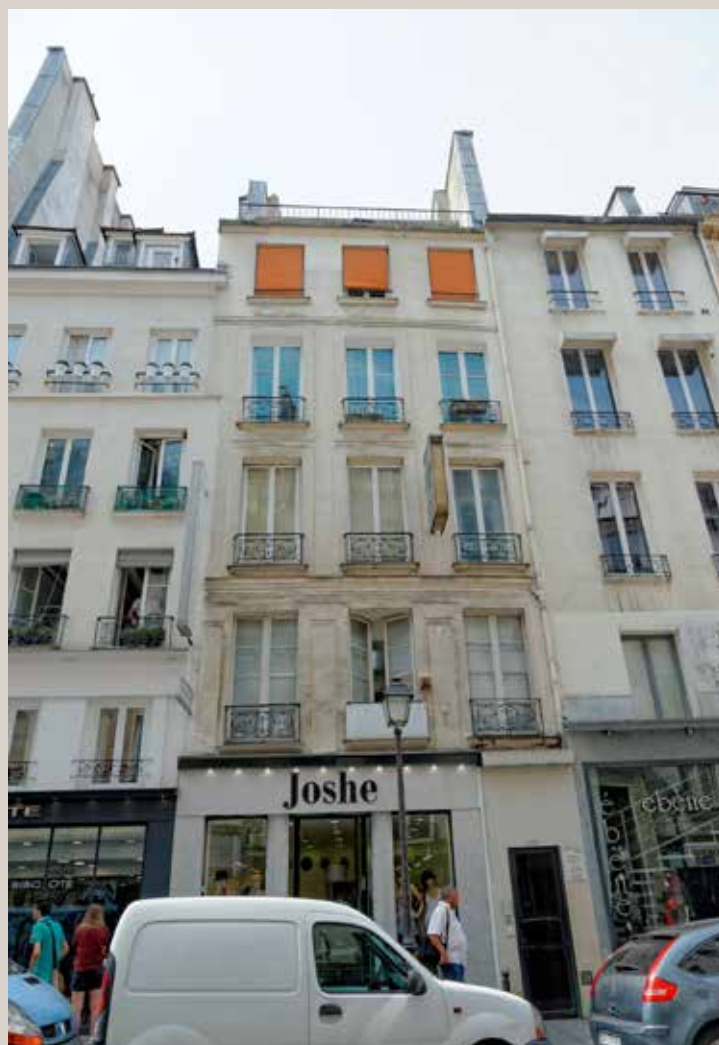
Vue actuelle de la façade sur rue.
