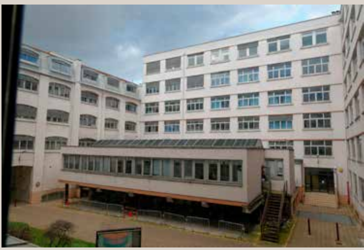
Vue actuelle de la deuxième cour et de la jonction entre le bâtiment du XIX e siècle et l’extension de 1950.
