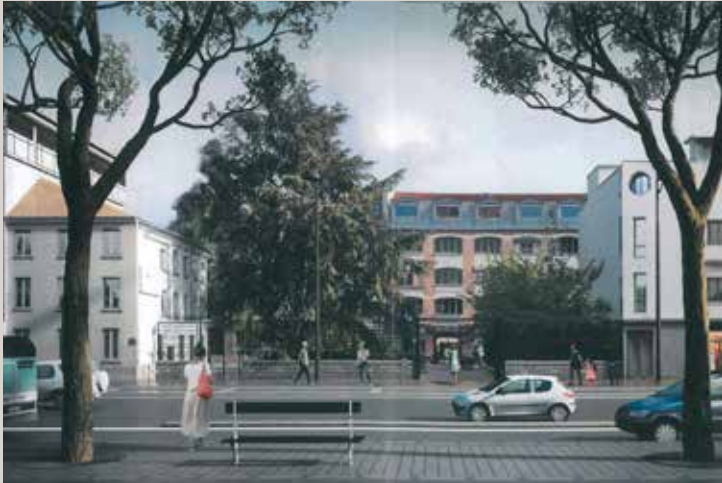
Vue des bâtiments de l'entrée du site dans leur état actuel (© AIA Architectes).
