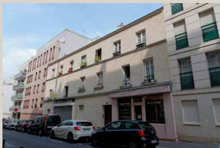
Vue actuelle de la façade sur rue.
