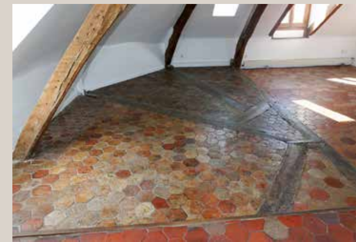
Vue du sol en tomettes au dernier niveau.
