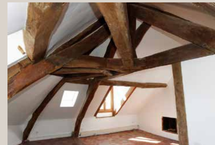
Vue de la charpente au dernier niveau.
