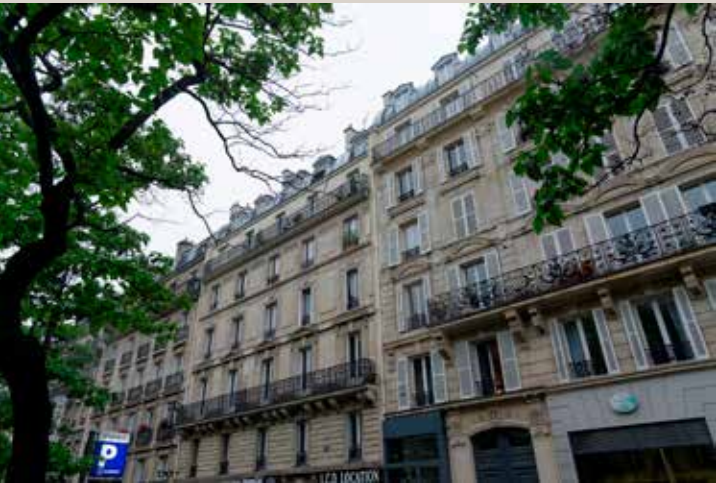
Vue actuelle de la façade sur rue.
