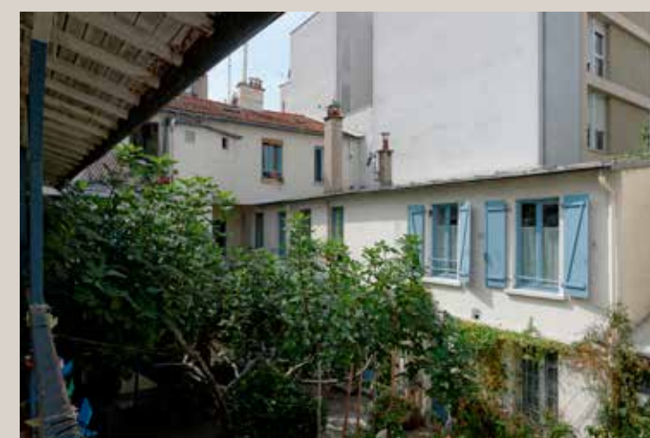
Vue actuelle de la cour depuis la coursive du premier étage.
