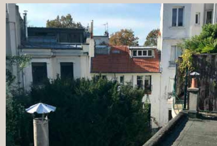
Vue de la façade sur cour, état existant (© Federico Masotto architecte).
