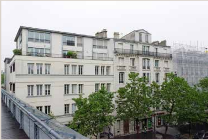
Vue actuelle de la façade sur rue.
