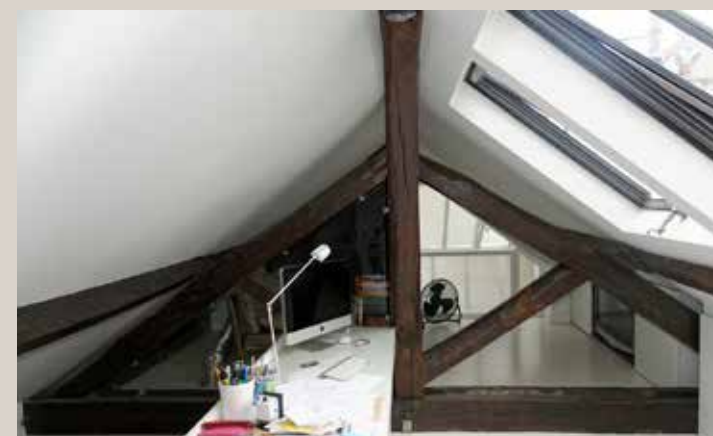
Vue actuelle de la charpente.
