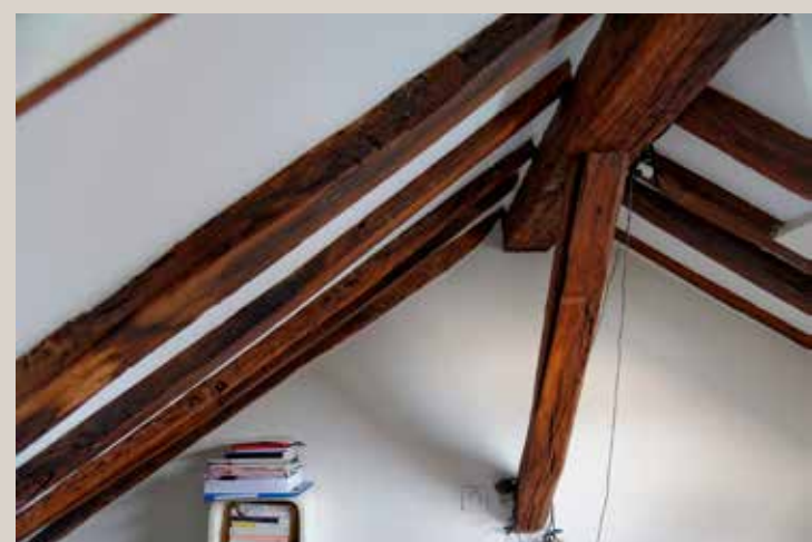
Détail de la charpente.
