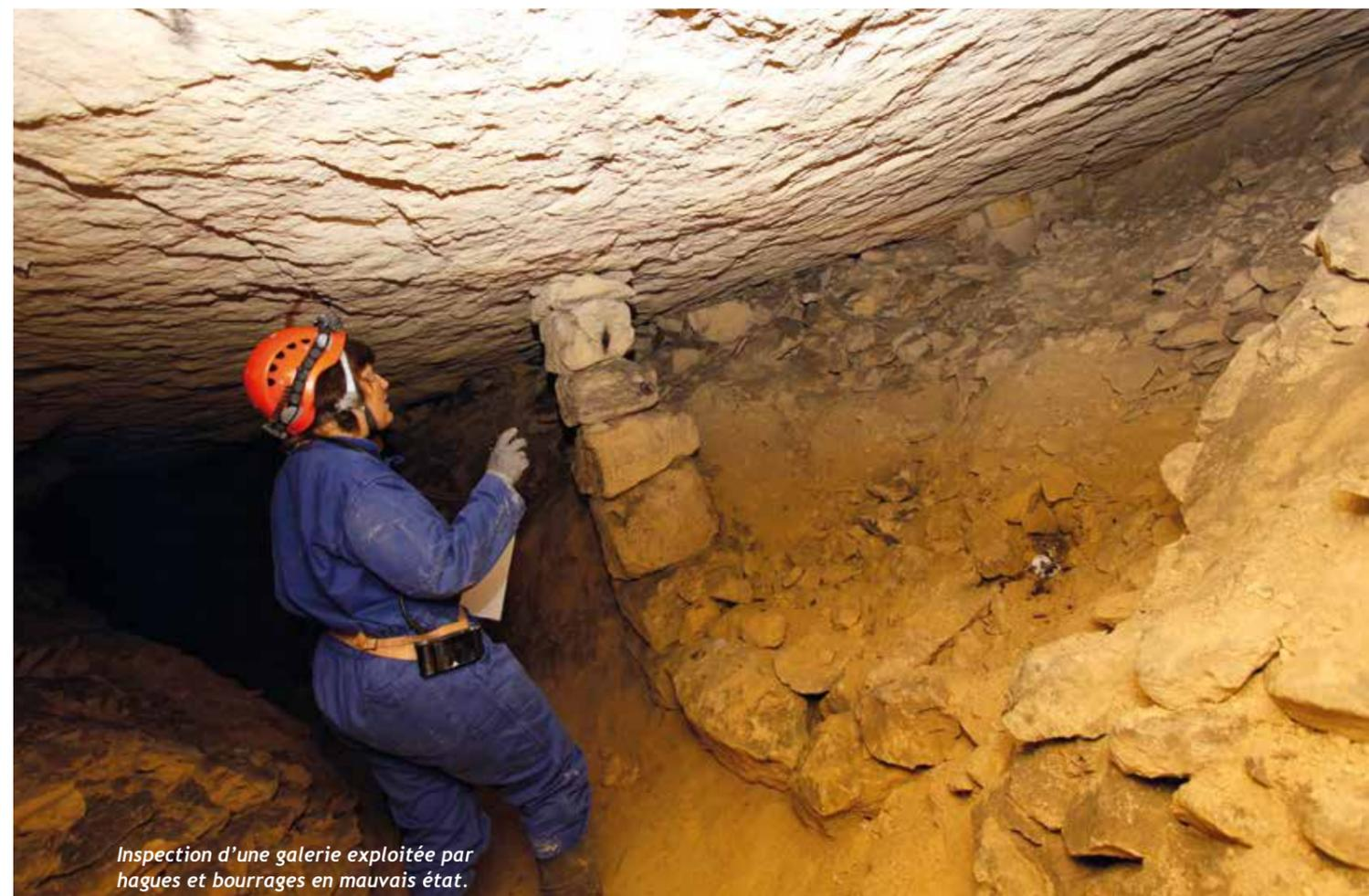
Inspection d'une galerie exploitée par hauges et bourrages en mauvais état.
