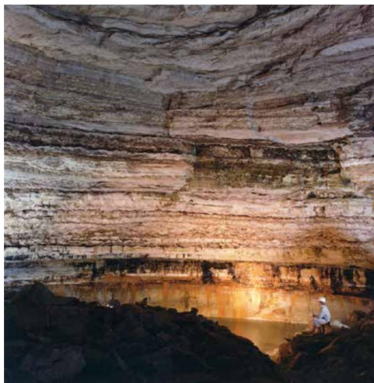
Fontis majeur dû à la dissolution de poches de gypse sous les voies de la Gare du Nord, repéré et conforté lors de la construction de la gare RER.
