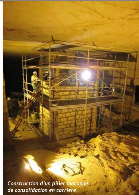
Construction d'un pilier maçonné de consolidation en carrière.
