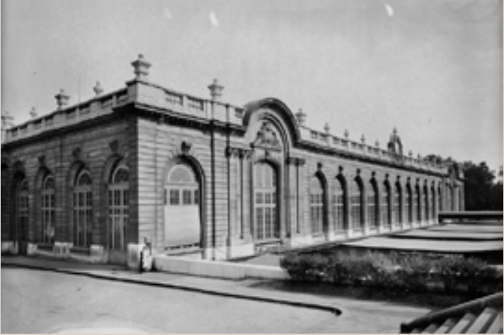
Gare des Invalides. Façade du côté de l'esplanade des Invalides en 1918 (© Charles Lansiaux / DHAAP / Roger-Viollet).
