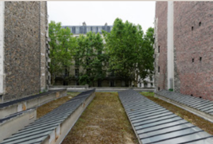
Vue du toit terrasse où s’ouvrent les lanterneaux filants.
