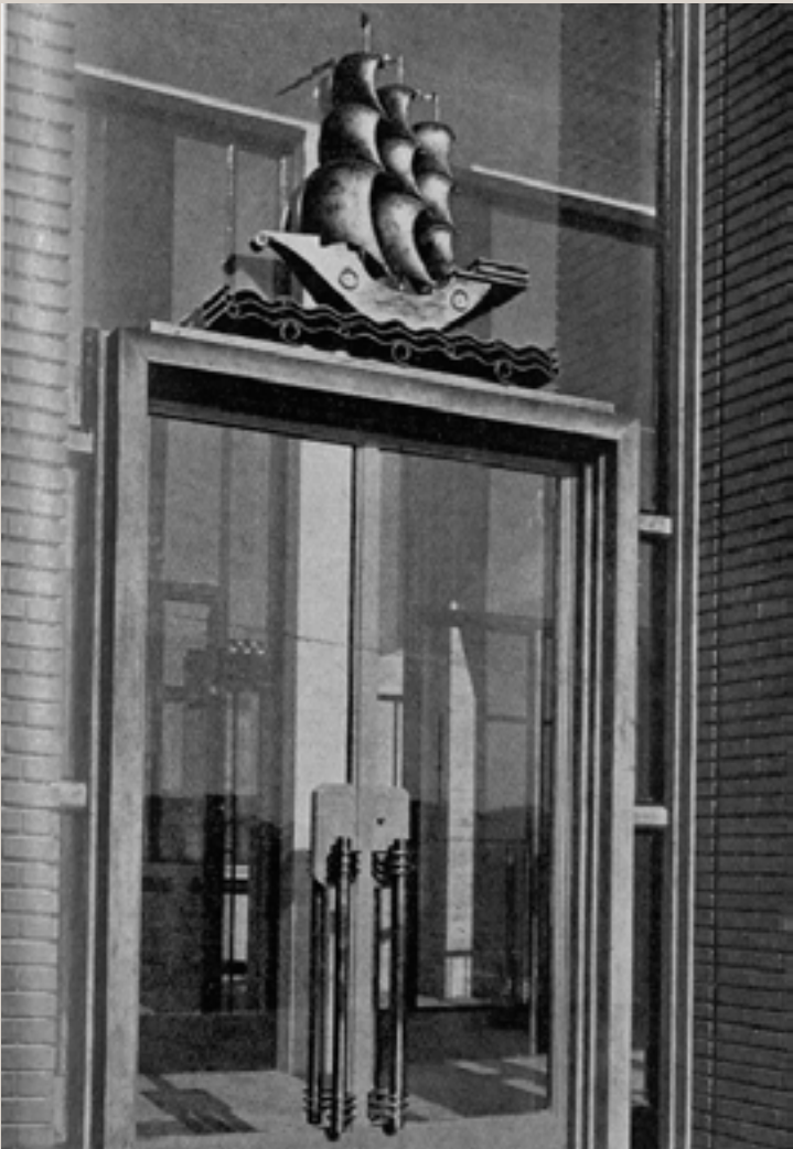
Porte d'entrée de l'institut conçue par Raymond Subes (publiée dans L'Architecture française , février 1941).
