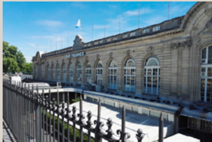
Vue actuelle de la gare (© Direction de l’Urbanisme / Ville de Paris).
