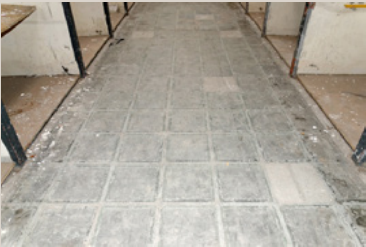
Vue des dalles de verre qui forment le plancher entre le sous-sol et le rez-de-chaussée.
