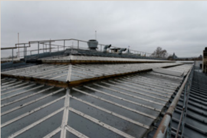
Verrière à lanterneau en terrasse de l’aérogare.
