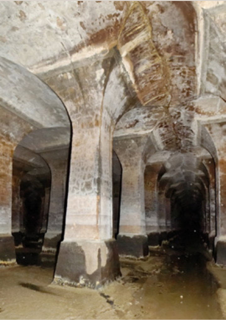
Vue actuelle du bassin supérieur Villejust du réservoir de Passy, bâti en 1858.
