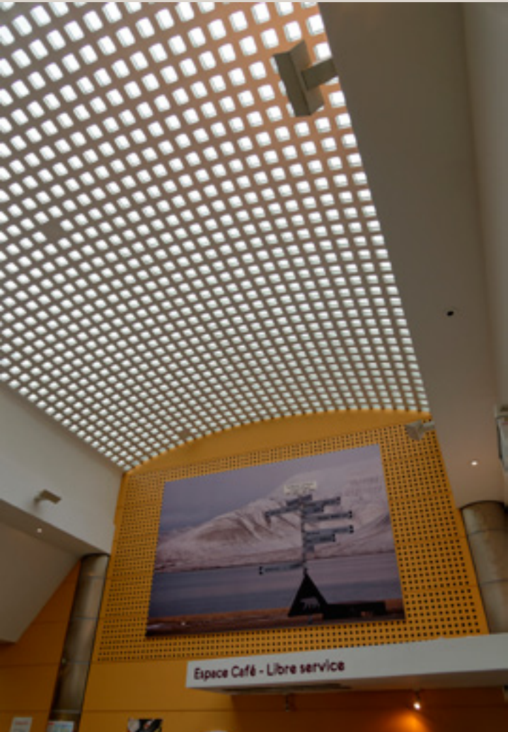
Voûte en pavés de verre de l’ancien hall de la gare (aujourd’hui restaurant administratif) à hauteur des quais.
