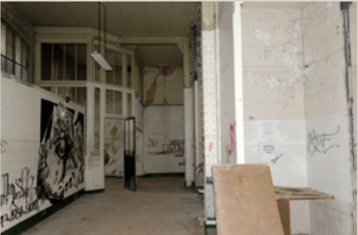
Vue intérieure montrant la structure métallique et une partie du cloisonnement d’origine.
