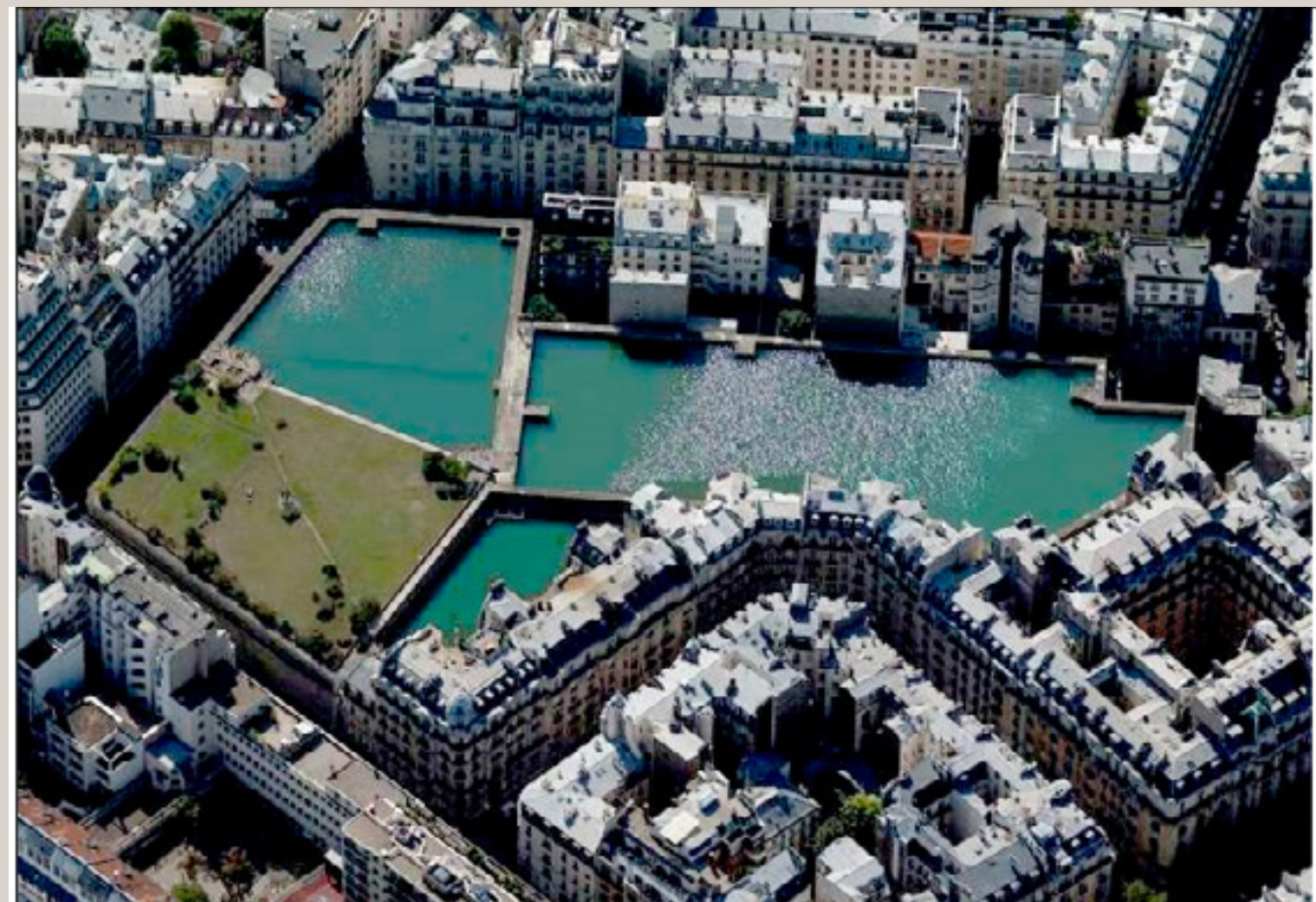
Vue aérienne des réservoirs.
