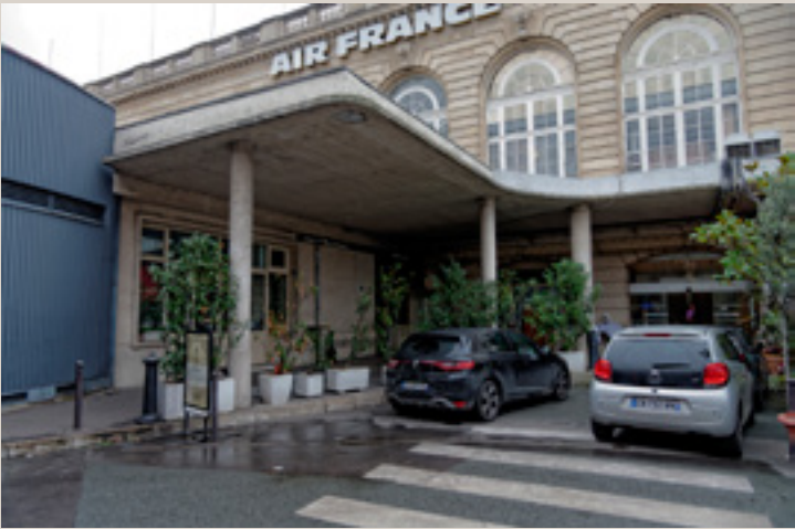
Marquise béton en contrebas de l’aérogare, côté ouest.
