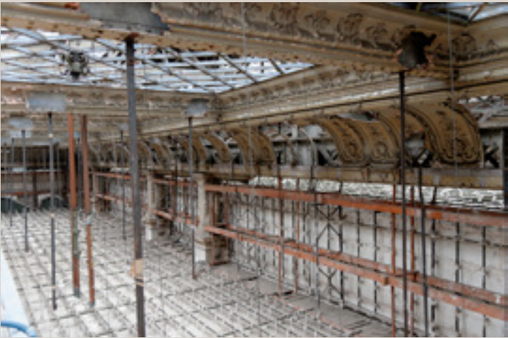
Décor d’origine de la partie haute de l’ancienne gare (1902).
