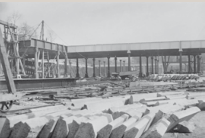
Construction de la gare des Invalides. Paris, vers 1900 (© Jacques Boyer / Roger-Viollet).
