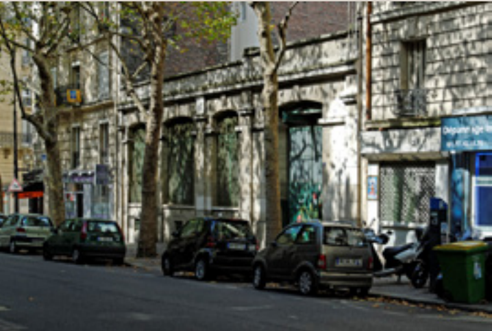
Vue récente du centre Laumière (19 e arrondissement).
