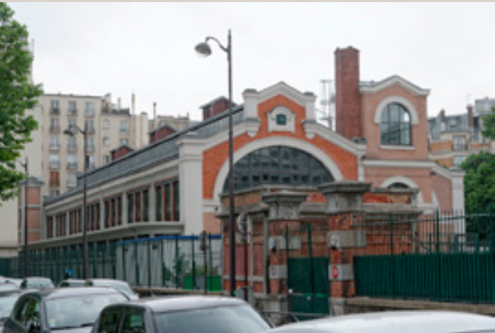
Vue actuelle de l'usine depuis le quai Louis Berliot.
