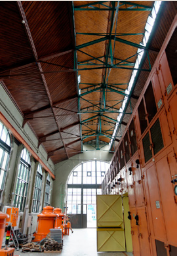
La charpente métallique et la halle de la salle des machines. À droite, les locaux techniques électriques aménagés à partir des années 1950.
