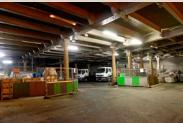
Vue actuelle du sous-sol de l’esplanade.
