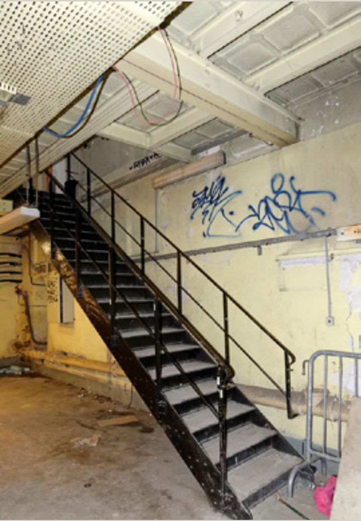
Vue de l’escalier métallique entre le sous-sol et le rez-de-chaussée dont le plancher est formé de dalles de verre.
