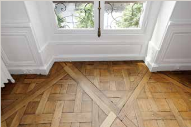
Détail d'un parquet en étage, 19, rue Cambon.
