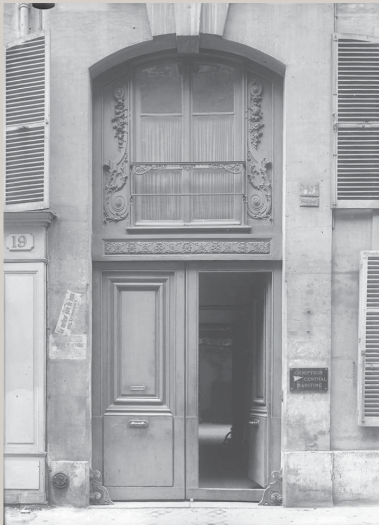
19, rue Cambon. Détail de la porte d'entrée et de la menuiserie de l'entresol (Commissariat du Vieux Paris, Charles Lansiaux 1921)
