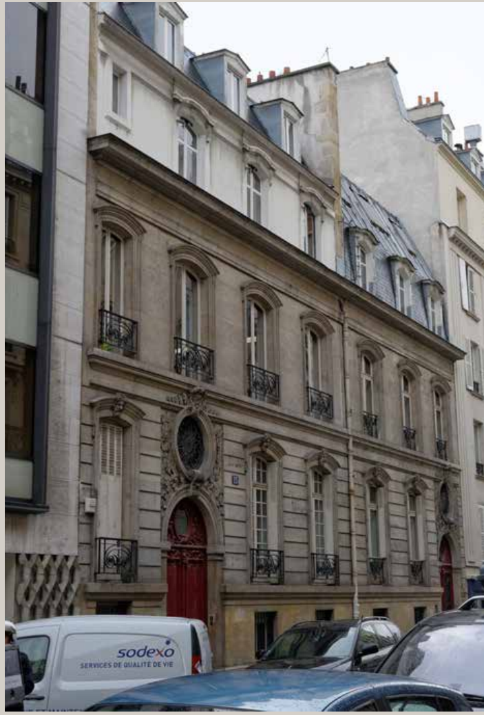
Vue actuelle de la façade rue de Bucarest.
