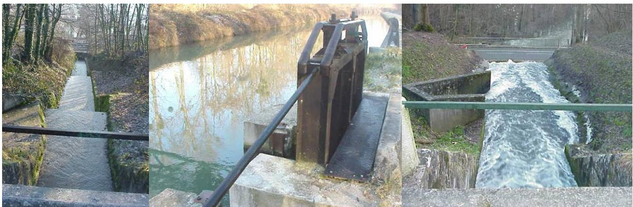
Figure 11 : Déversoir et vannage de Bois-Talon et déversoir de la Fontaine des Ances
