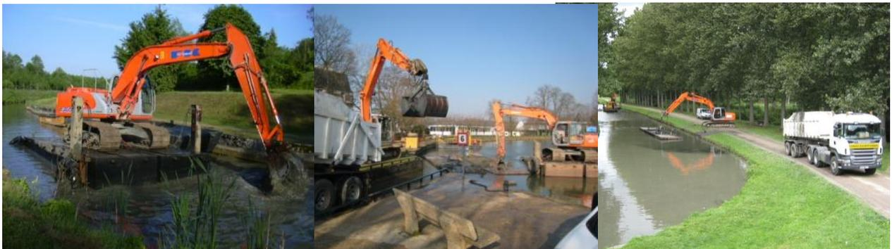
Sur l'ensemble du **canal St. Denis et St. Martin** lors des opérations de chômage prévues respectivement en 2017-2018 et 2015-2016 le **dragage de type mécanique** aura lieu à **sec**.
