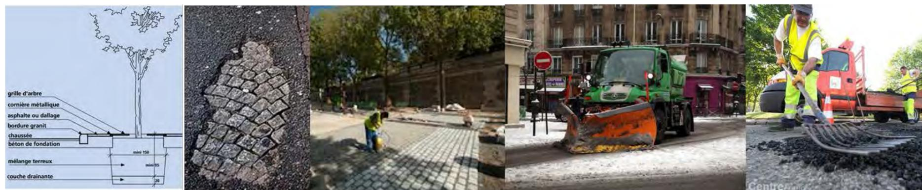
Figure 66 : Illustration des contraintes à prendre en compte concernant la conception (doctrines de voirie), la construction (sous-couches routières historiques à Paris), l'exploitation (salage...) et l'entretien (nids de poule...)
