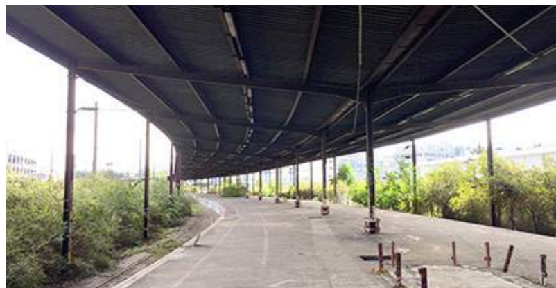
Vue état actuel de l'ancien quai de tri postal et son auvent de couverture
