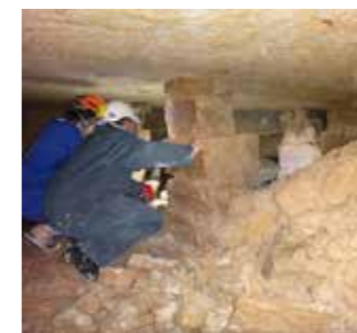
À droite : Murs de barrage édifiés entre les cales à bras
