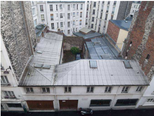
199 m 2 de panneaux photovoltaïques
