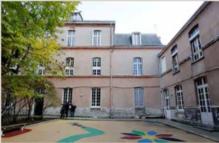
Vue récente du revers du bâtiment principal, donnant sur le second jardin.
