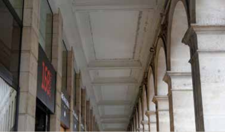
Plafonds à caissons de la galerie sur la rue de Rivoli, qui seraient conservés en l’état.
