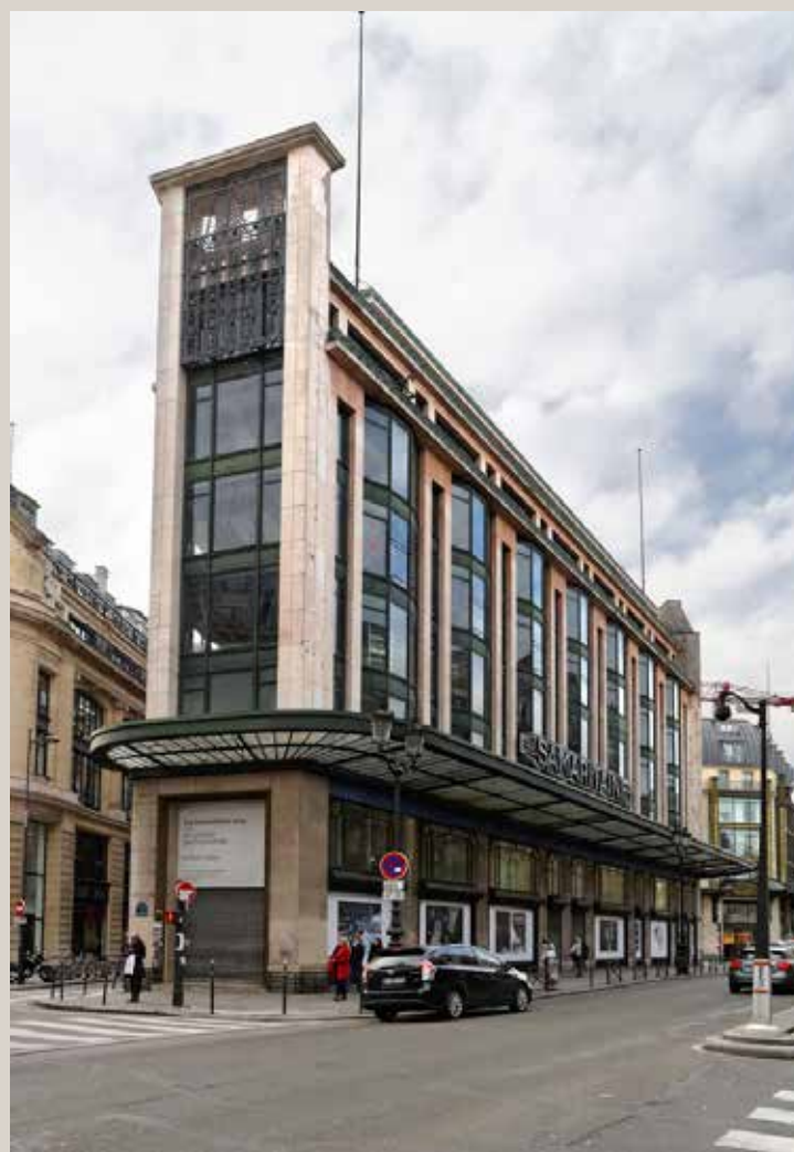
Vue actuelle du bâtiment à l'angle de la rue de Rivoli et de la rue Boucher.
