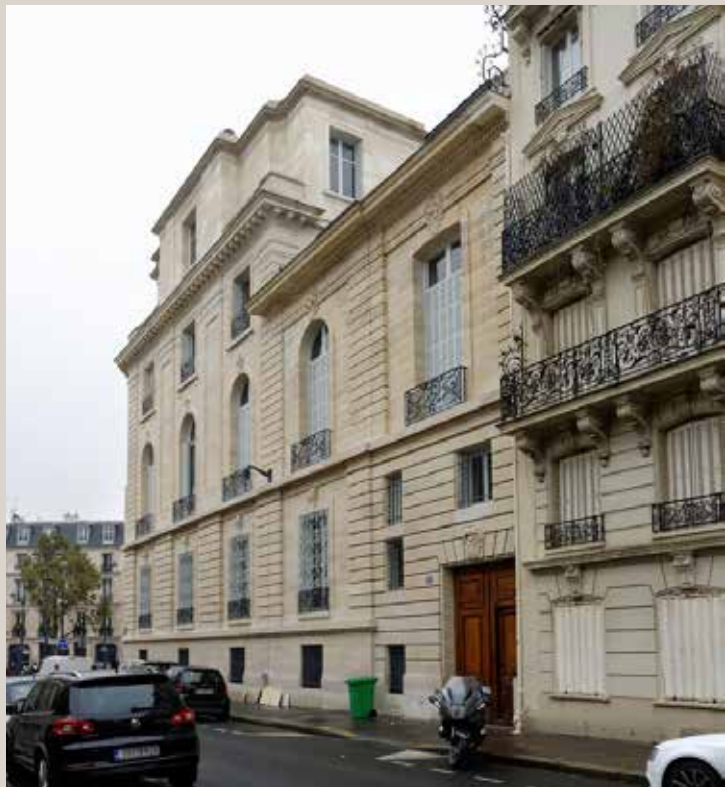
Vue actuelle de la façade, rue Auguste-Vacquerie.
