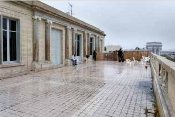
Vue actuelle de la terrasse côté avenue d'Iéna.
