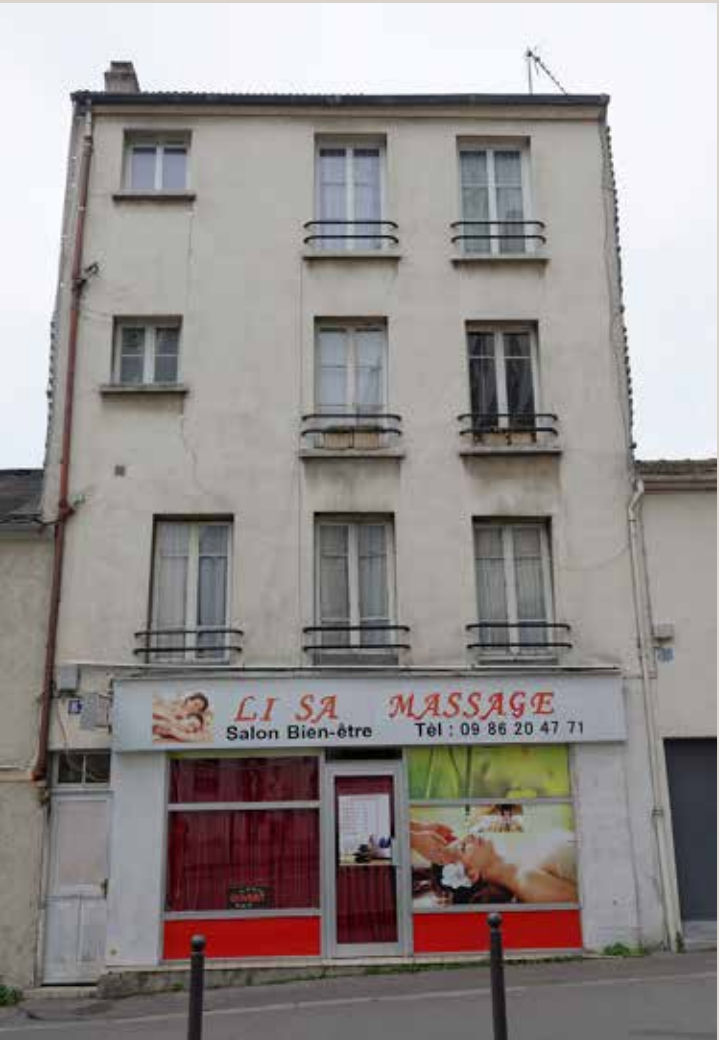
Vue actuelle de la façade sur rue.
