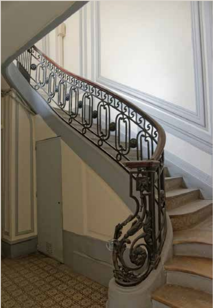
Vue actuelle du départ de l’escalier principal.
