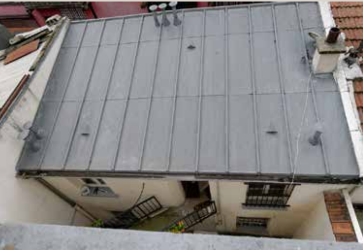
Vue plongeante sur le second corps de bâtiment.
