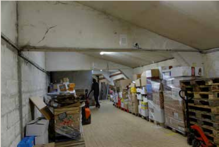
Vue actuelle de l'entrepôt.
