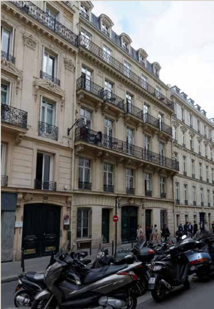
Vue actuelle de la façade sur rue.
