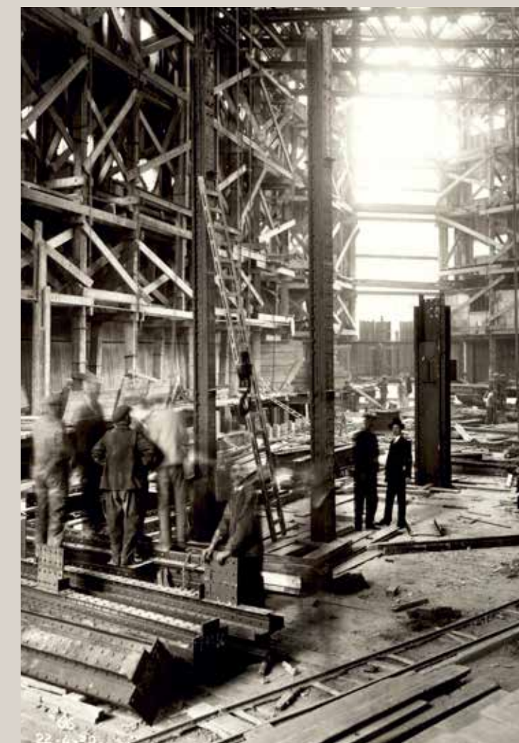
Vue du magasin en construction en 1930 (Documentation Samaritaine).
