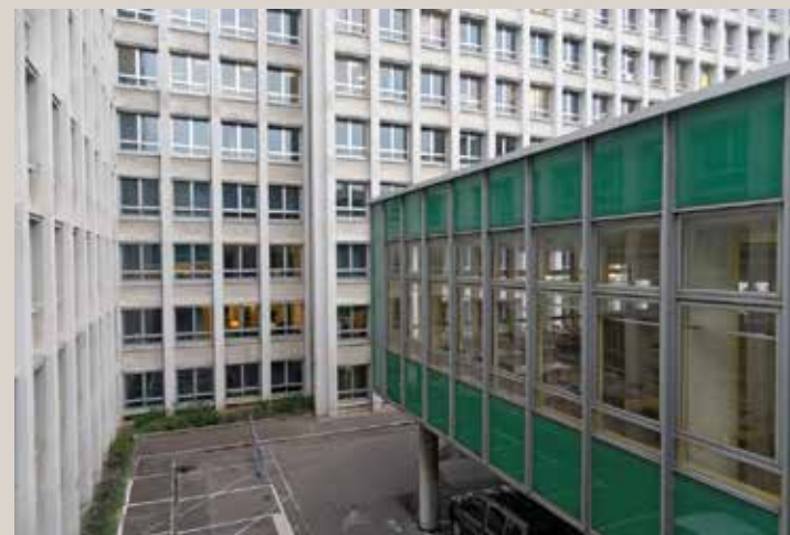
Vue actuelle du bâtiment, prévu démoli, qui accueille le restaurant du personnel
