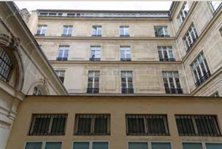
Vue actuelle du bâtiment à rez-de-chaussée dans la cour (au premier plan) et de l'aile en retour du bâtiment sur rue prise depuis le n° 96.
