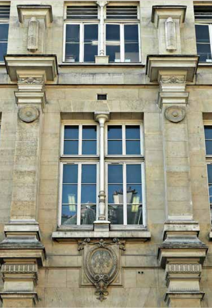
Détail de la façade rue du Louvre.
