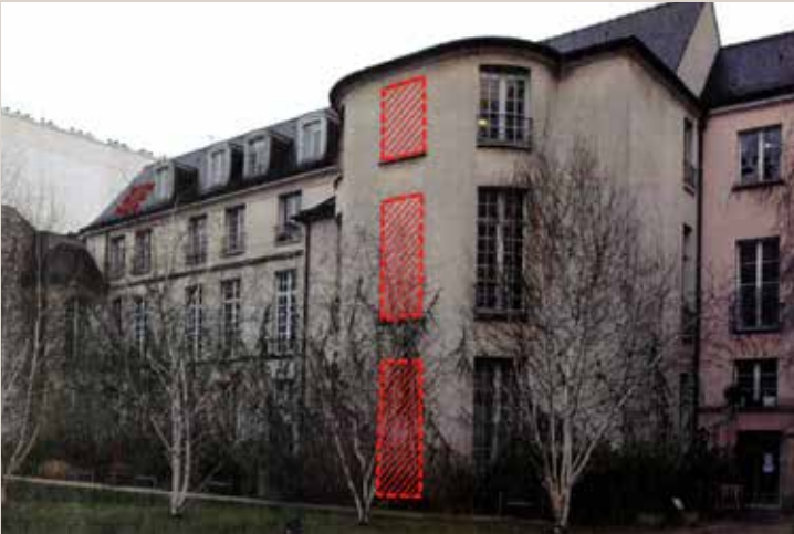
Vues actuelles des façades sur le jardin (en bas et en rouge, les percements projetés) (© Sahuc & Katchoura).
