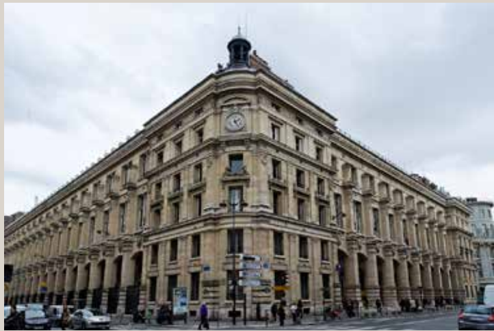
Vue de la poste en 2013 à l’angle de la rue Etienne-Marcel et de la rue du Louvre.
