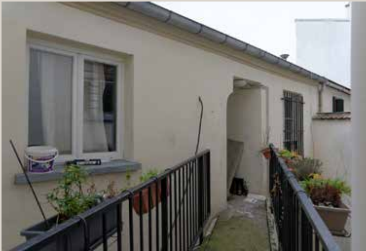
Vue actuelle de la passerelle de liaison entre les deux bâtiments.
