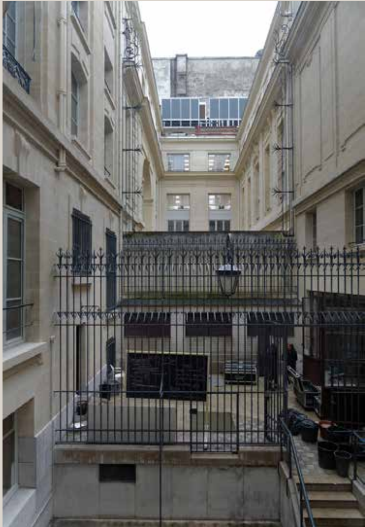
Vue actuelle de la cour. Une passerelle est prévue entre les deux ailes au premier étage.
