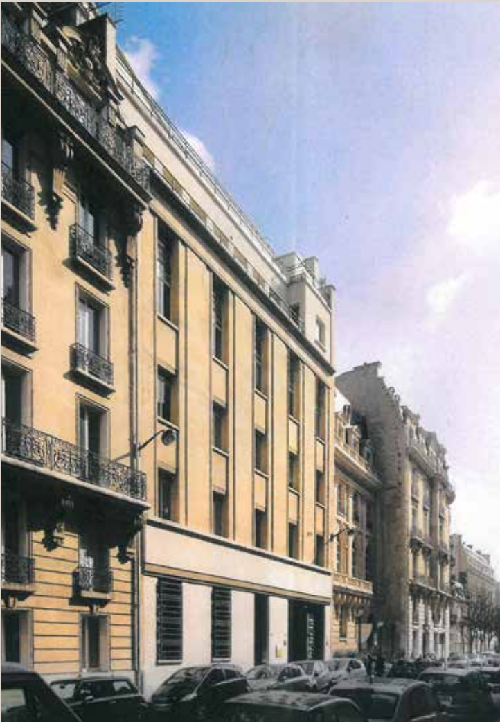
Vue actuelle de la façade avenue d'Eylau (© DTACC).
