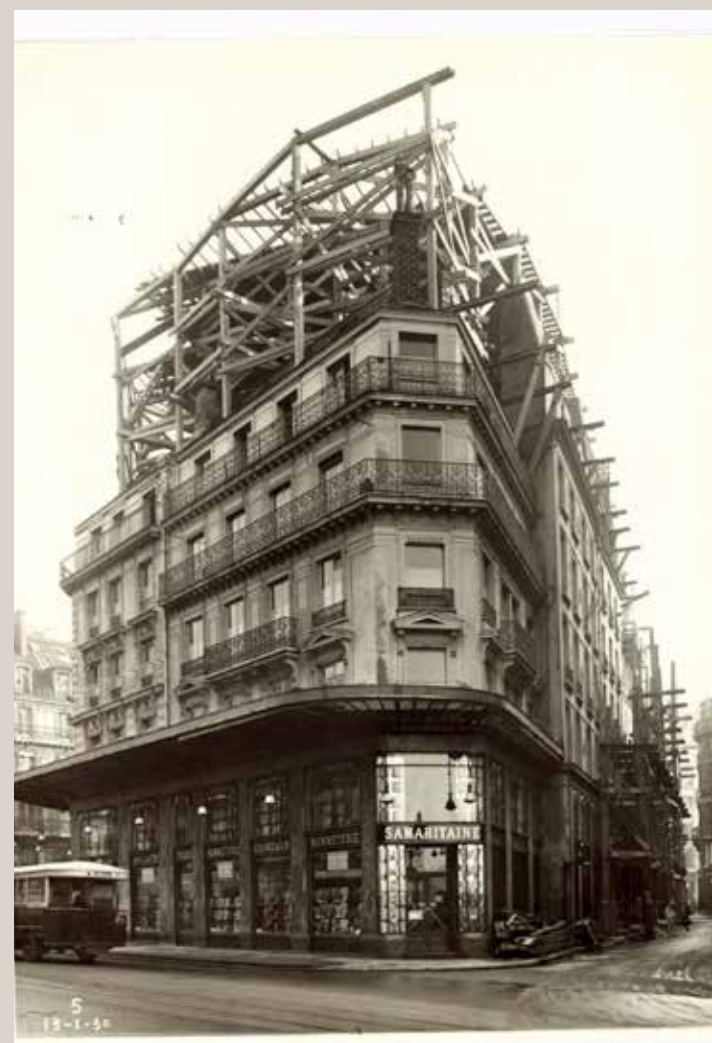
Vue de l'ancien magasin, à rez-de-chaussée et à l'entresol, au début des travaux de 1930 (Documentation Samaritaine).
