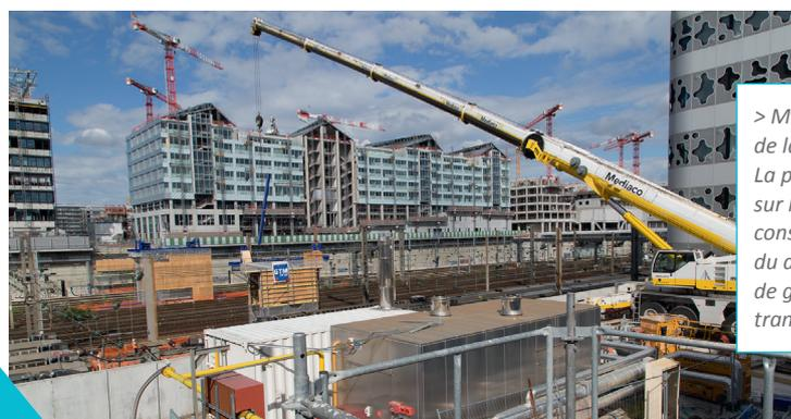
> Mise en place des éléments de la palée de lancement sur la pile de la passerelle. La palée est un appui provisoire sur lequel repose l'ouvrage lors de sa construction, elle est de plus équipée du dispositif qui permettra à l'ouvrage de glisser et d'être réglé transversalement au cours du lancement
