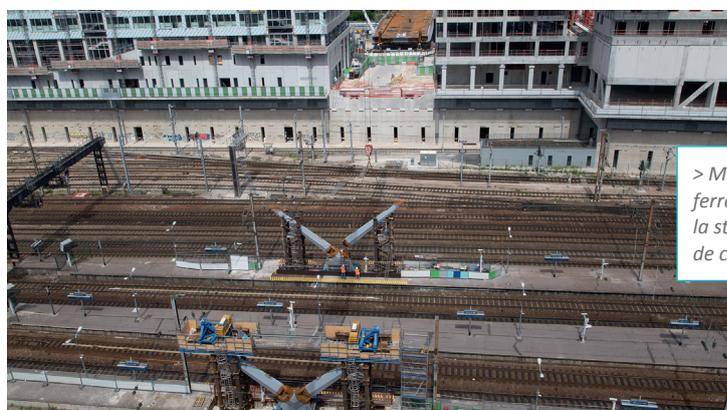
> Mise en place des piles dans le domaine ferroviaire – en arrière-plan on aperçoit la structure du tablier du pont en cours de construction
