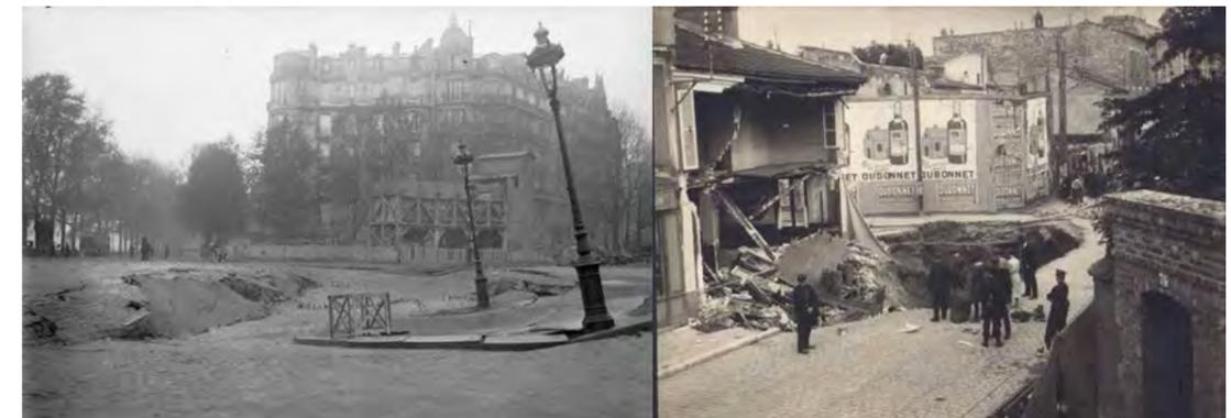
Figure 45 : Exemples de dégradations liés à des fontis (place de l'Alma, 1915, Malakoff 1928)
