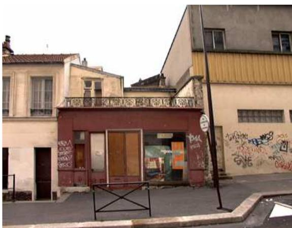
Le bâti hétérogène est formé d'une boutique à rez-de-chaussée, surmontée de deux adjonctions d'un étage disposées en retrait et adossées aux mitoyens. De médiocre qualité, cet ensemble sera démolé pour la construction d'une habitation.
