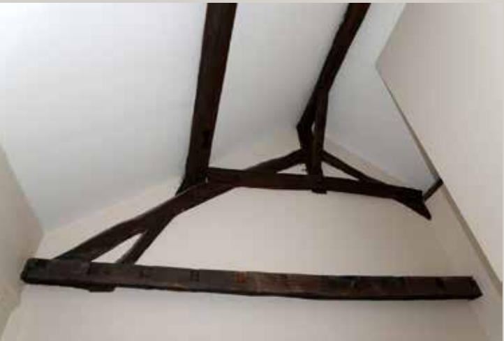
Détail de la charpente encore visible dans le bâtiment d’angle.
