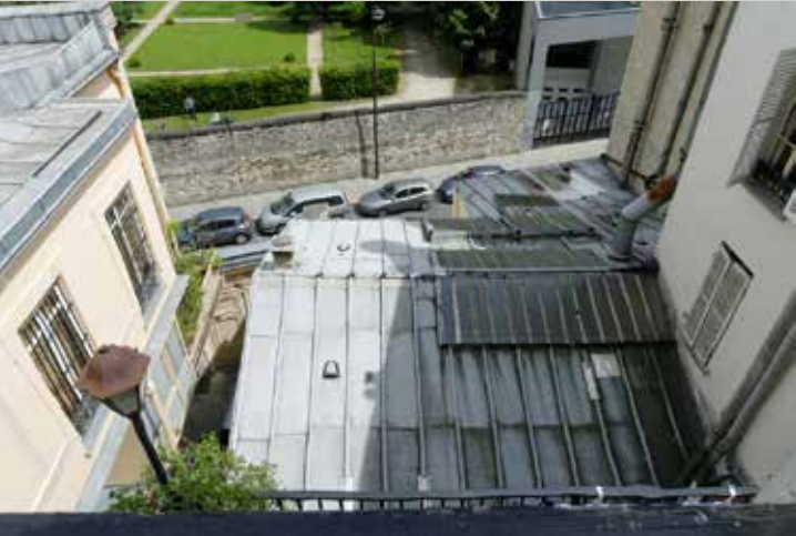
Vue actuelle de la toiture de l'ancien atelier, construit en 1863-1865 à l'emplacement d'un jardin.
