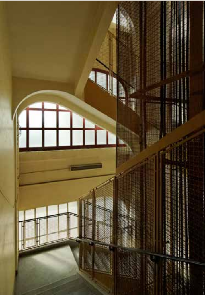
Vue de l'escalier nord-est dont la démolition est demandée (état actuel).
