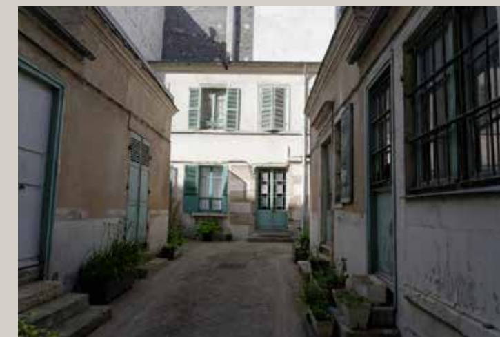
Vue de l'allée centrale. Au fond, le bâtiment dont la transformation est demandée.
