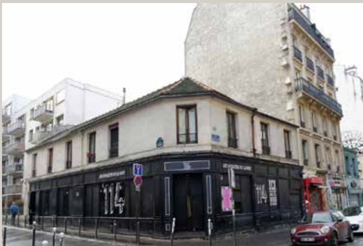
Vue actuelle à l’angle des deux voies.
