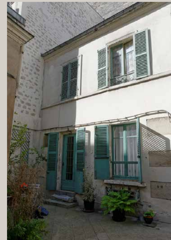
Vue actuelle de la façade dont bâtiment du fond. Des assises de pierre encadrent la porte.
