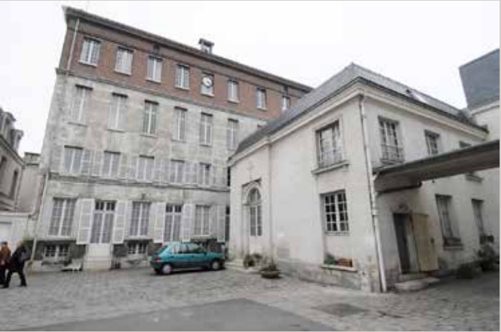
Vue actuelle de la première cour. Au fond, le bâtiment Saint-Paul dont la démolition est prévue.
