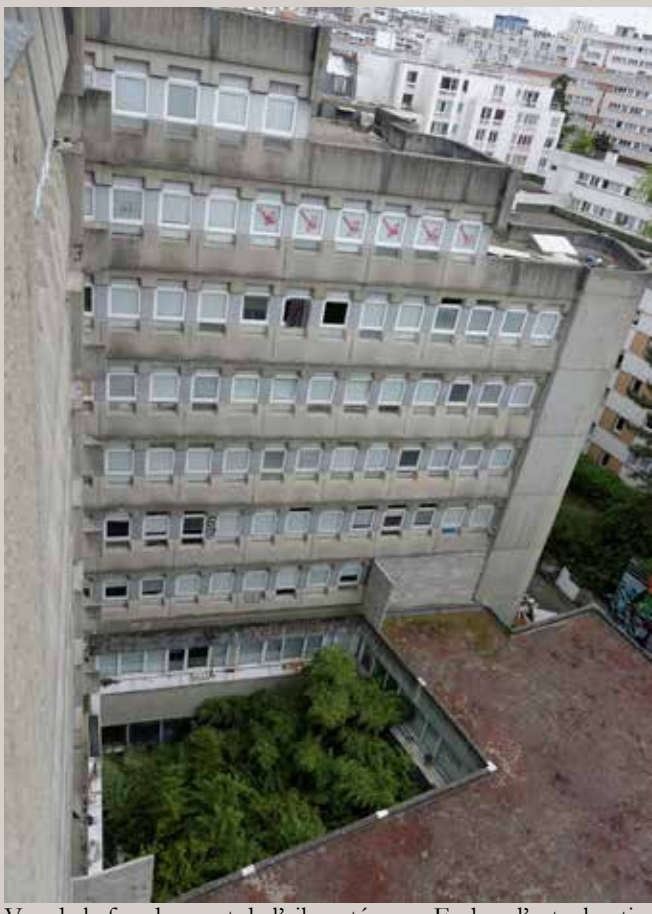
Vue de la façade ouest de l'aile coté cour. En bas, l'actuel patio éclairant les niveaux du socle arrière.
