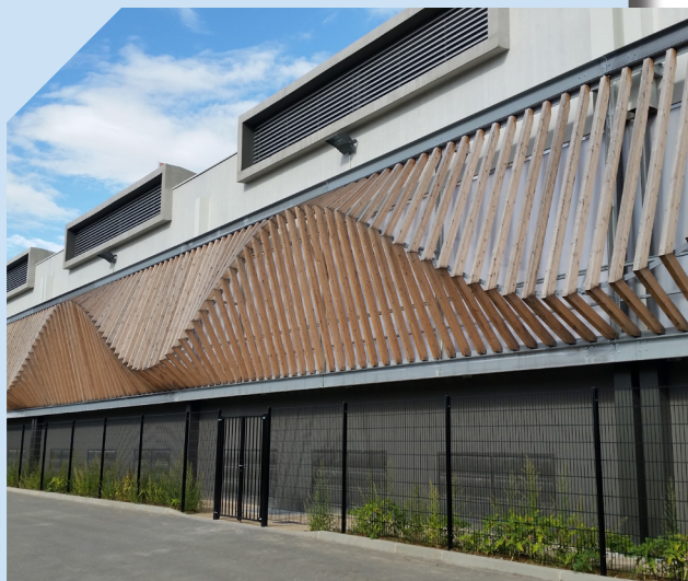
Chapelle International (Paris 18 e ) - Façade ouest photo © SOGARIS
