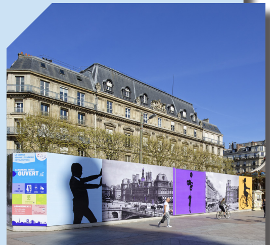
Chantier de rénovation du parking Hôtel de Ville : SAEMES travaille avec ses entreprises impliquées à minimiser les nuisances, notamment celles causées aux riverains
