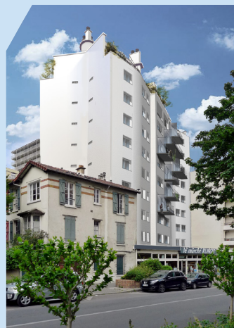
Energies POSIT'IF rue Lancon perspective 1 rue de Rungis après travaux © Equateur
