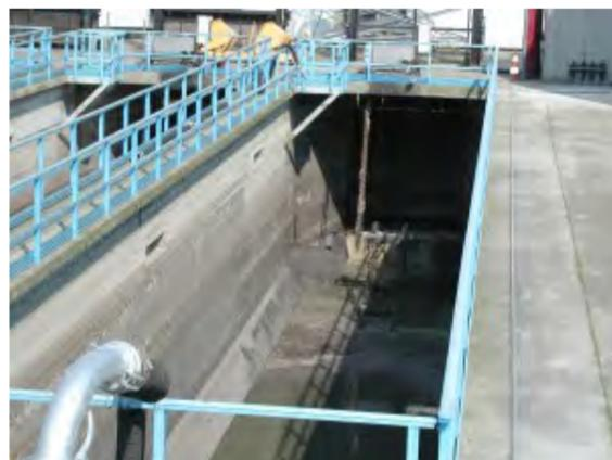
Stocker les effluents dans le déversoir d'orage avant restitution au réseau en fin de pluie.
