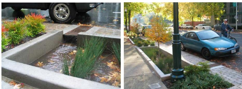
**Noues urbaines à Portland (Oregon-USA) : Ce dispositif permet une déconnection complète les eaux de ruissellement de la chaussée et du trottoir. A noter que les eaux de ruissellement de chaussée sont traitées par les noues basses et les eaux de ruissellement du trottoir par des noues plus hautes (photos et coupe : Mairie de Portland)**
