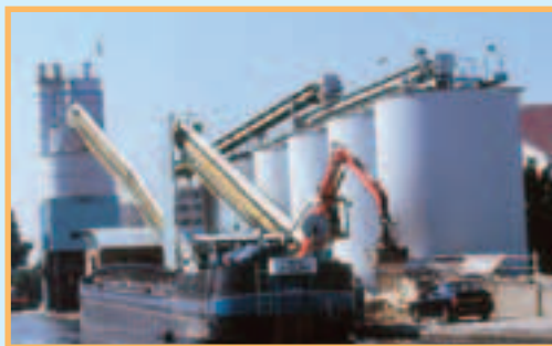
Centrale à béton.
