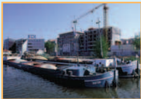
Le canal Saint-Denis.
