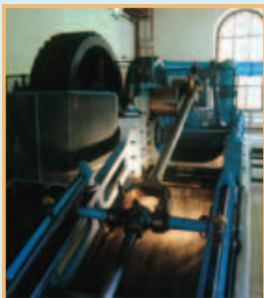
Usine de Trilbardou - salle des pompes hydrauliques.
