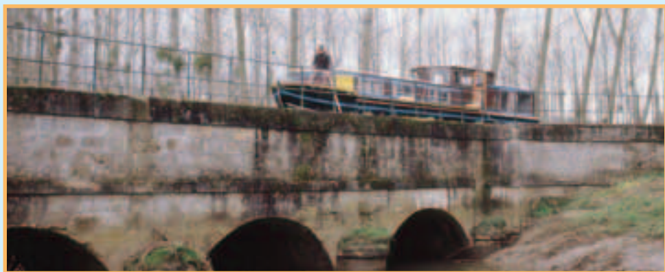
Pont canal du Clignon.
