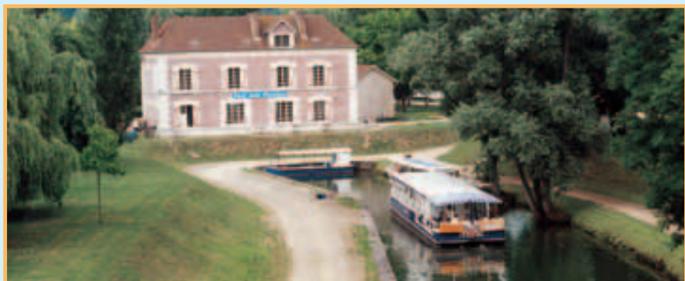
Rivière d'Ourcq canalisée : Port-aux-Perches.
