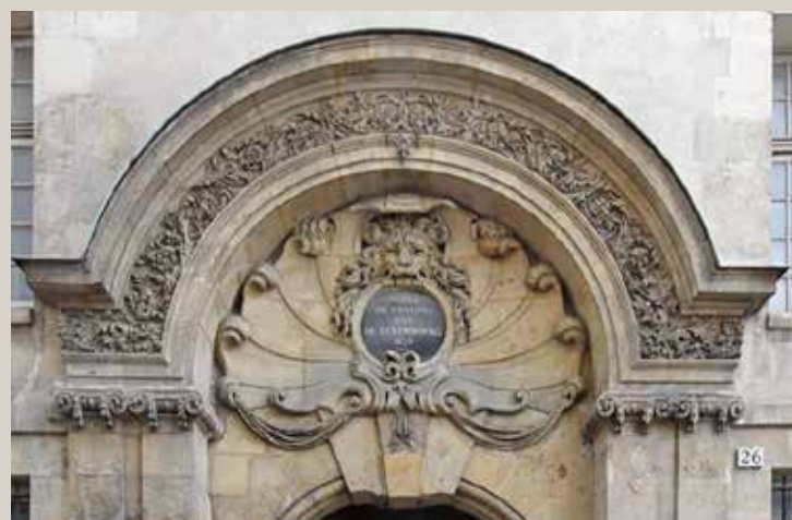
Détail du porche sur rue.
