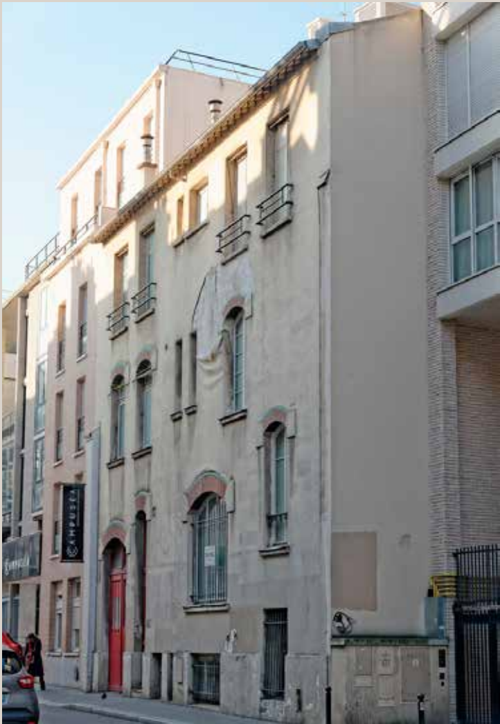
Vue actuelle de la façade sur rue.
