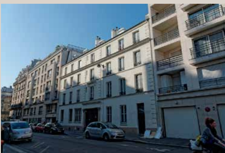
Vue actuelle de la façade sur rue.
