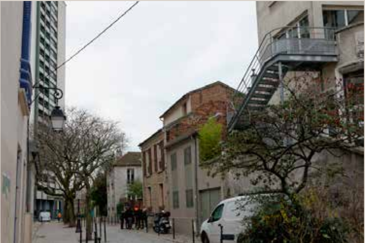
Vue actuelle de l’escalier de secours en métal en façade rue Taclet.
