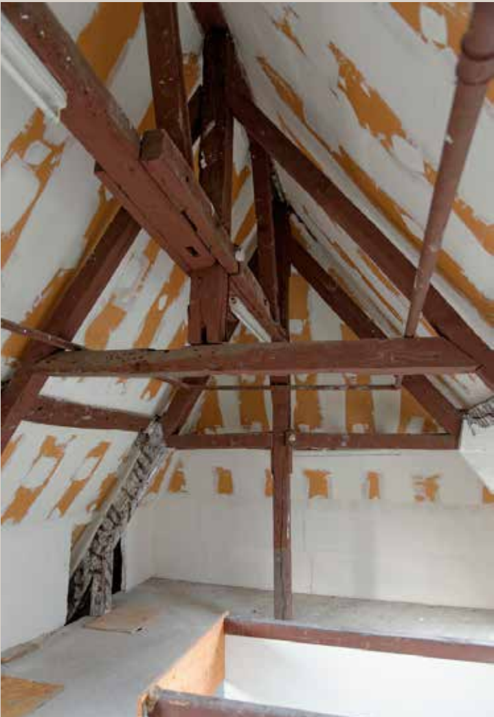
Vue actuelle de la charpente visible au niveau des combles.
