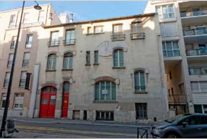
Vue actuelle de la façade sur rue.
