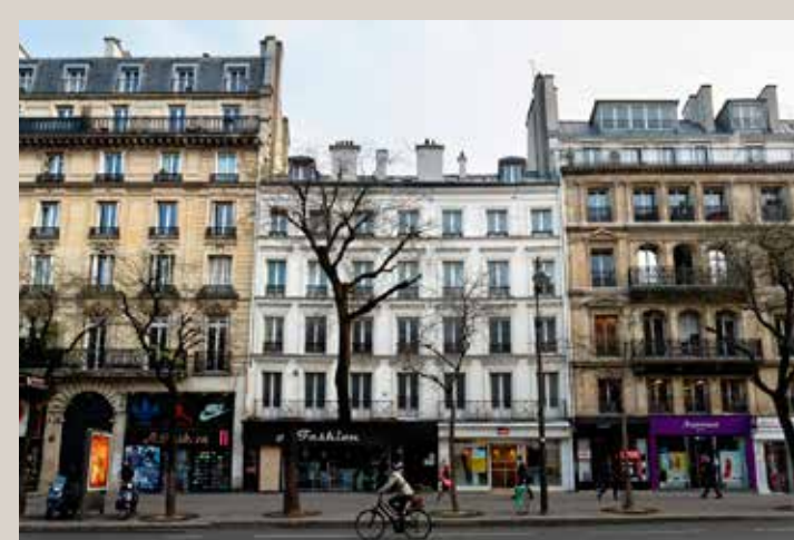
Vue actuelle de la façade sur rue.
