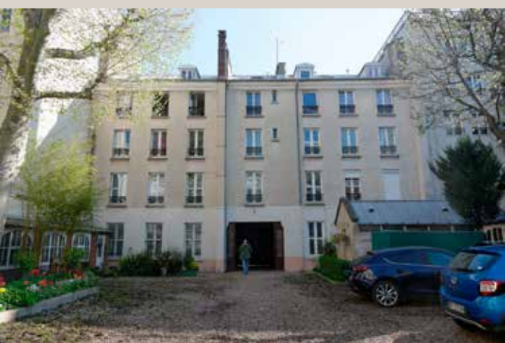
Vue actuelle du revers du bâtiment sur rue.
