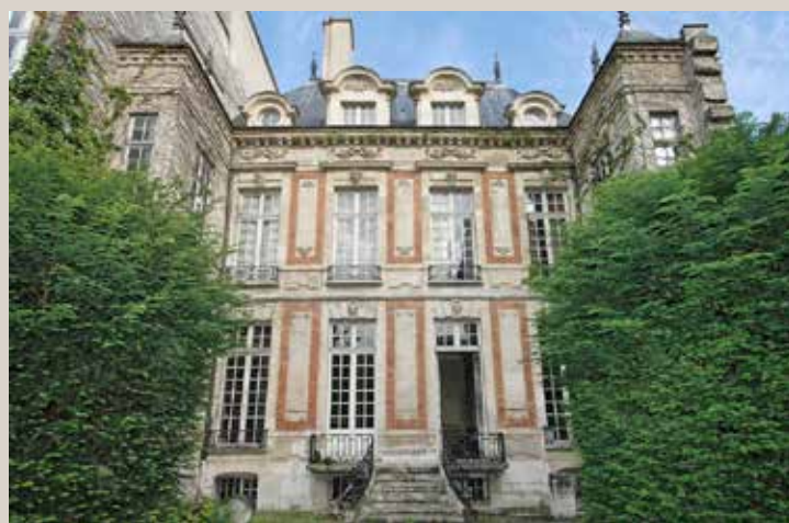
Vue récente de la façade sur jardin du corps de logis principal.
