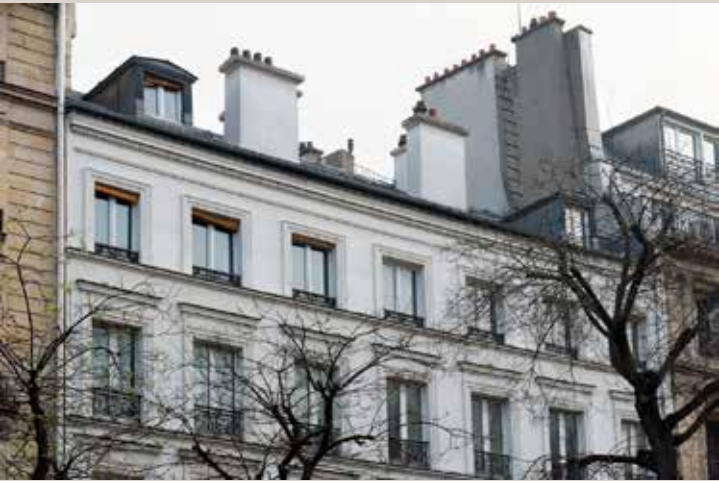
Détail de la façade sur rue.
