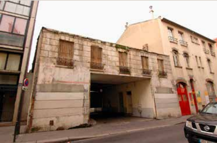
Vue avant démolition en 2006 du n° 75, rue du Château-des-Rentiers et de sa liaison avec le n° 77.
