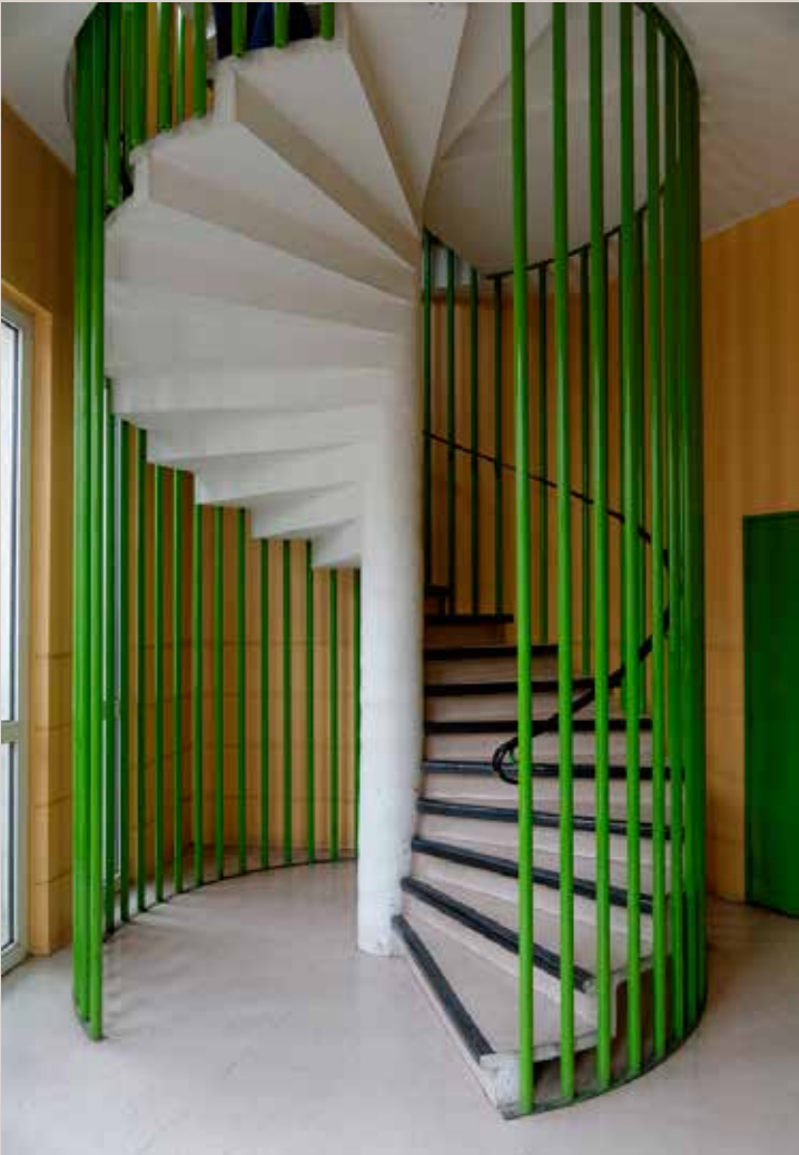
Vue actuelle de l’escalier situé dans le hall d’entrée.
