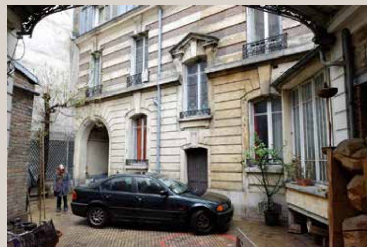
Vue de la façade arrière sur cour.
