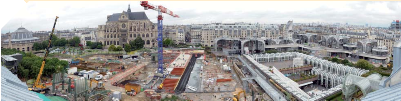
Panorama du chantier des Halles.
