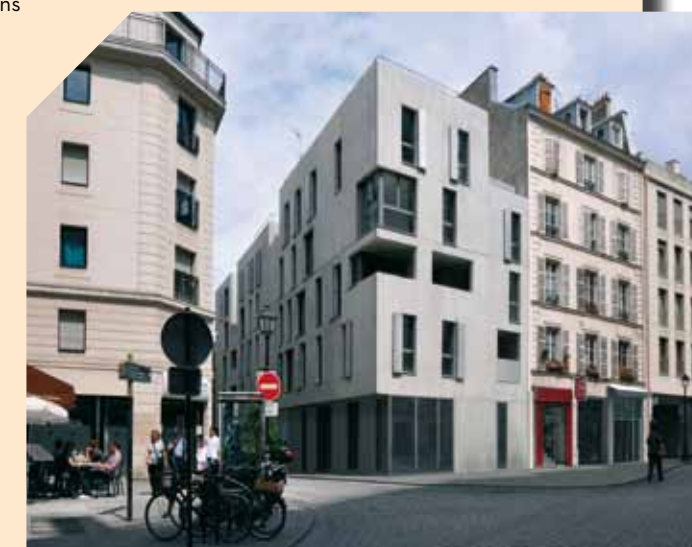
Rue Bouchardon, Paris 10e, 11 logements sociaux.
