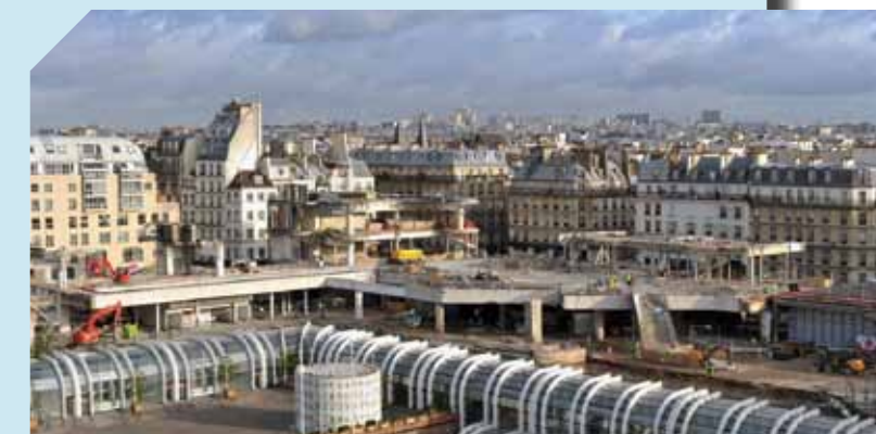
Réaménagement des Halles : démolition des pavillons Willerval, Paris 15 e .
