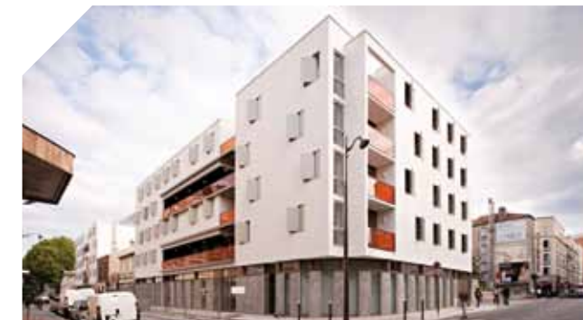
Opération de construction au 139-141 rue Castagnary, Paris 15 e .
