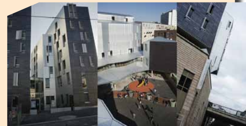
Sur la ZAC Paris Rive Gauche à Paris 13 e , la mixité du programme M9C s'étend de la rue du Chevaleret à la rue des Grands-Moulins permettant la cohabitation d'un théâtre, d'une école élémentaire et primaire et de 66 logements sociaux. LAN architecture
