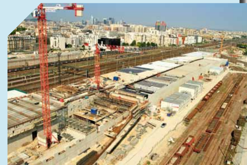
Dalle de couverture des activités ferroviaires le long des voies ferrées.
