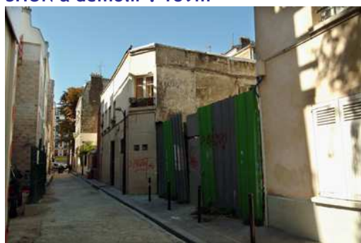
9-11 passage Duhesme (18 e arr.) SHON à démolir : 189m 2
