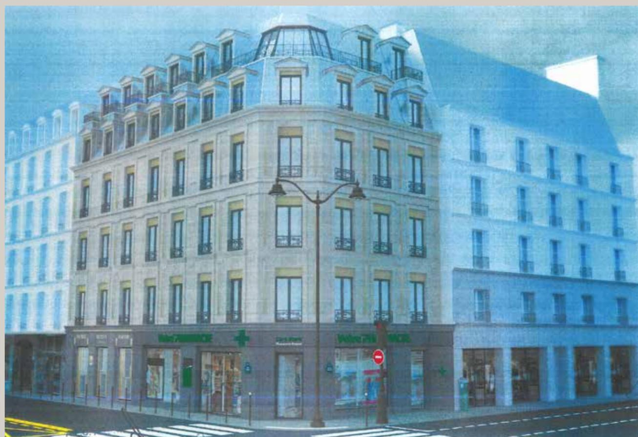
Insertion du projet de surélévation (© A.L.C. Architecture). La toiture gagnerait un second rang de lucarnes (rentrantes et munies de balconnets) ; l'angle serait entièrement vitré.
