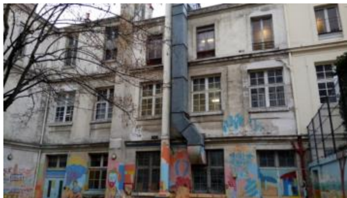
Ravalement de façade
