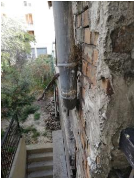
Ravalement de façade
