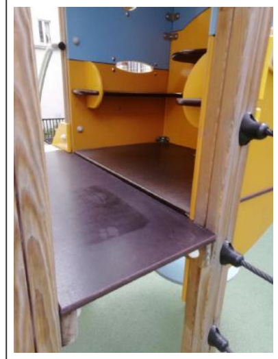
RDC - Cour (Tboggan)
