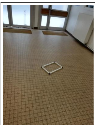
RDC - Hall d'entrée élémentaire
