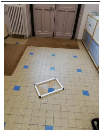
RDC - Hall d'entrée
