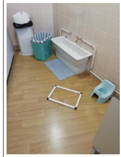
21 - R+1 - Salle de bains - Sol
