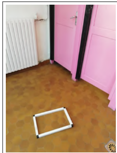
38 - RDC - Sanitaires - Sol
