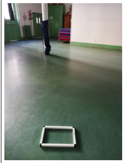
6 - RDC - Préau - Sol
