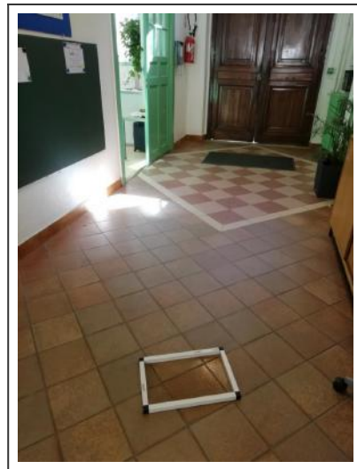
35 - RDC - Hall d'entrée - Sol
