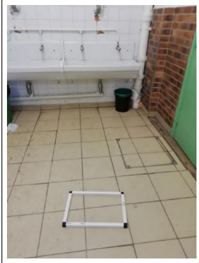
39 - RDC - Lavabos - Sol
