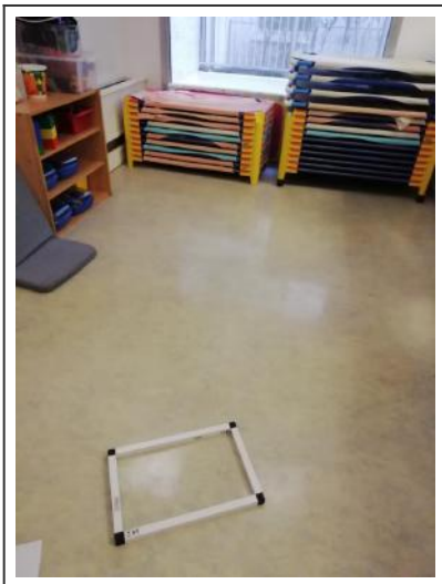
3 - RDC - Dortoir des grands - Sol
