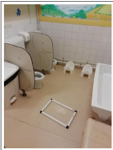
15 - RDC - Sanitaires des grands - Sol
