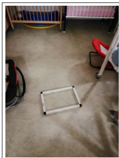
12 - RDC - Dortoir des bébés - Sol
