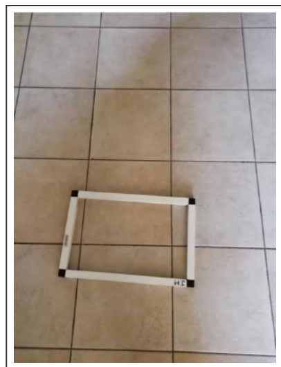
24 - RDC - Hall d'entrée
