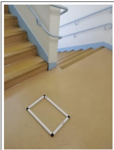
12 - R+1 à R+2 - Volée d'escalier
