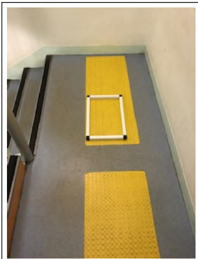
Demi-palier volée RDC à R+1 - Bande podotactile
