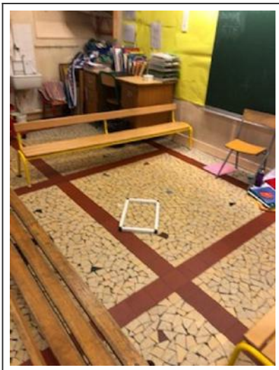
RDC - Salle de classe - Sol
