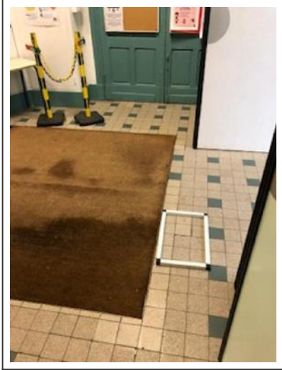
RDC - Accueil - Sol
