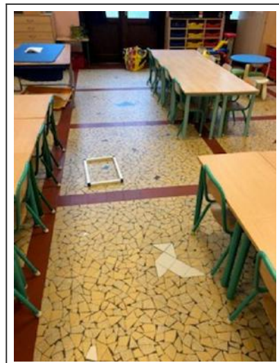
RDC - Salle de classe - Sol
