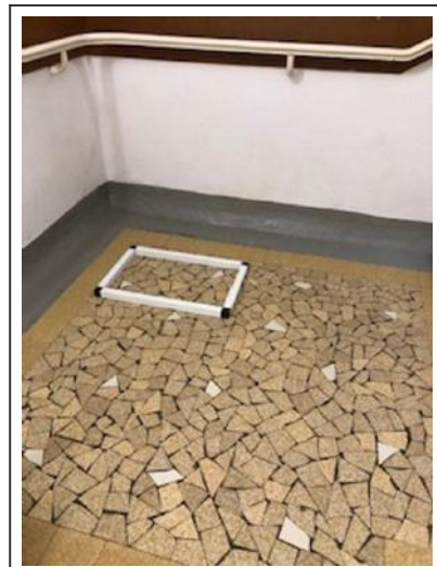
Demi-palier volée RDC à R+1 - Sol
