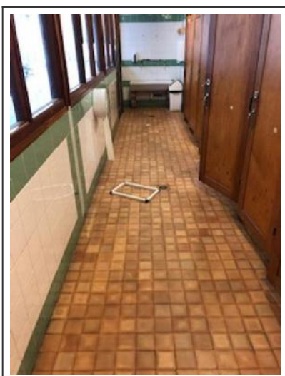
RDC - Sanitaires - Sol
