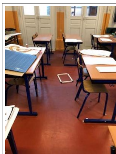
RDC - Salle de classe - Sol
