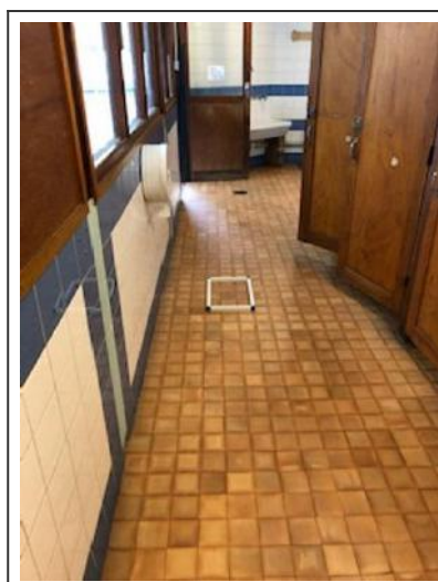
RDC - Sanitaires - Sol
