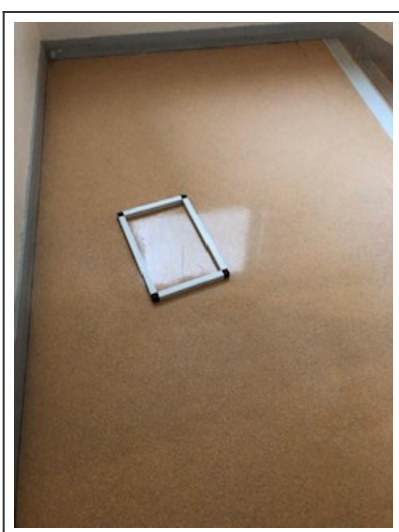
Demi-palier volée RDC à R+1
