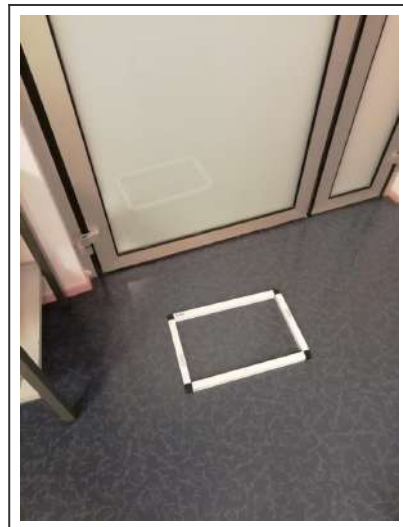
24 - R+4 - Hall - Sol
