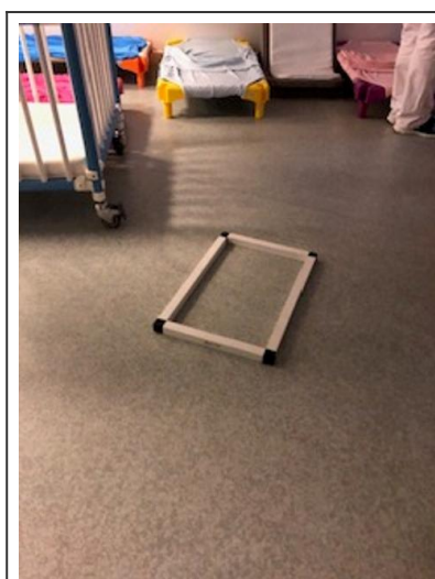
RDC - Dortoir - Sol
