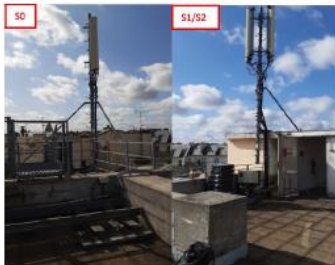
Vue de la zone technique
