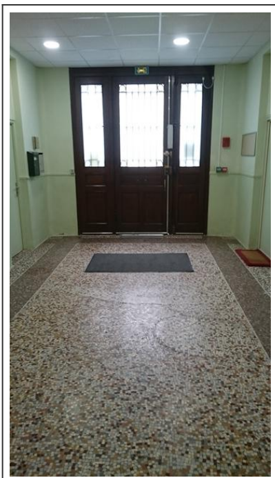
Hall d'entrée RDC
