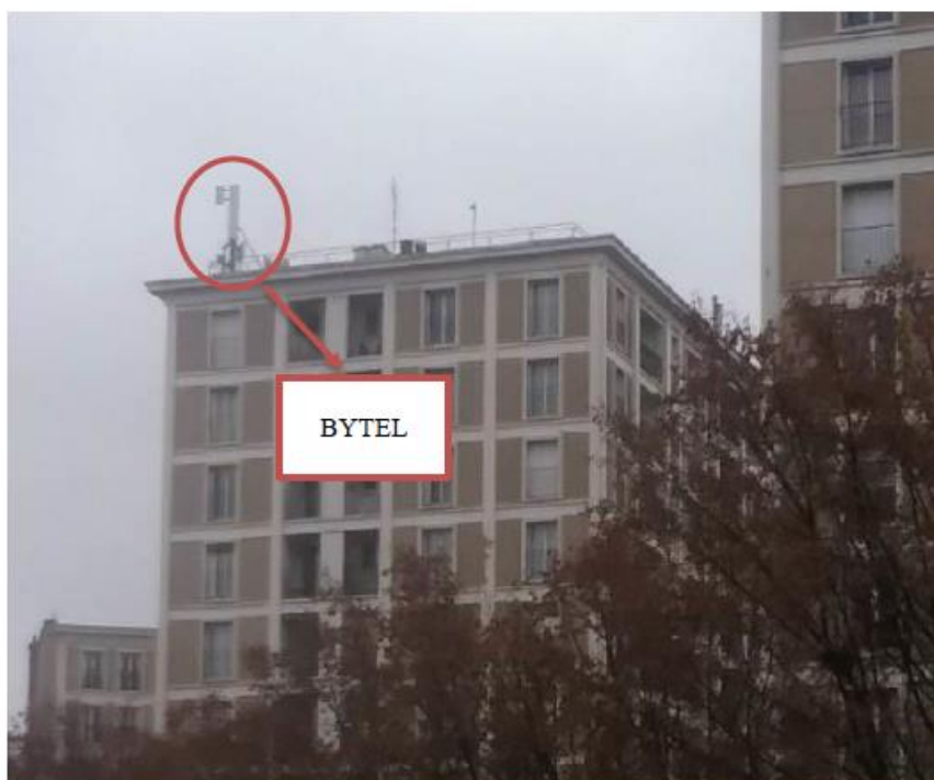
Etat projeté : pas de modification visible
