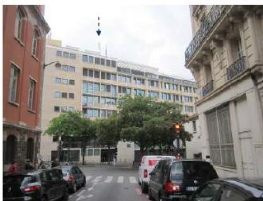
Etat projeté : Installation de l'antenne SFR
