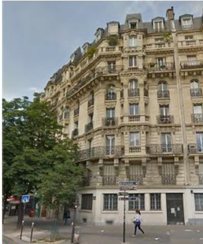
DP 6 Photo de l'existant
