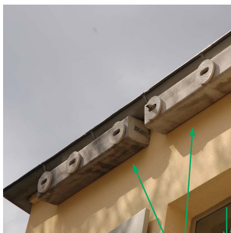
Dispositifs apposés à l'immeuble
