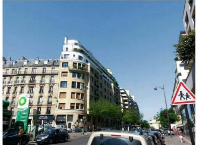
DP 8 - Photo de l'existant, vue lointaine
