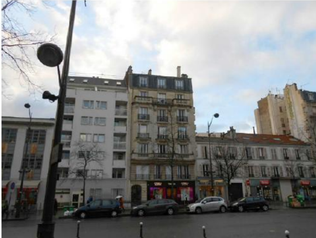
DP 7.1 - Photo de l'existant
