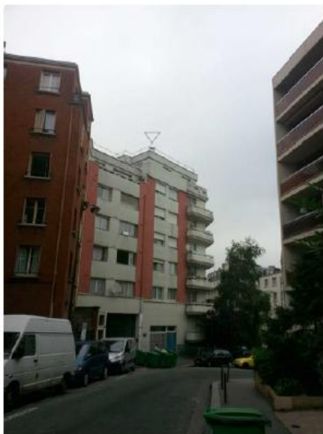
DP 7.1 - Photo de l'existant
