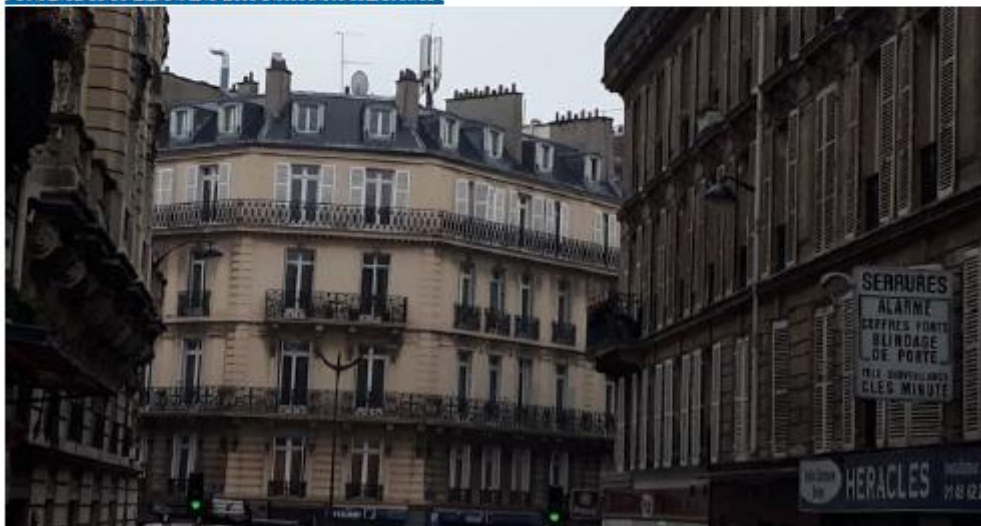
Etat projeté : pas de modification visible
