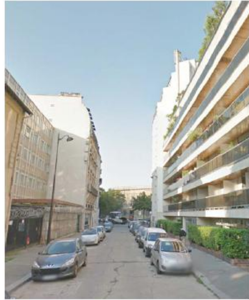
DP 8 - Photo de l'existant, vue lointaine
