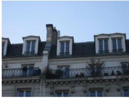
PHOTO AVANT TRAVAUX
