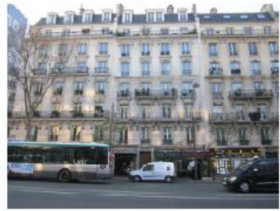
PHOTO DEPUIS LA RUE AVANT TRAVAUX
